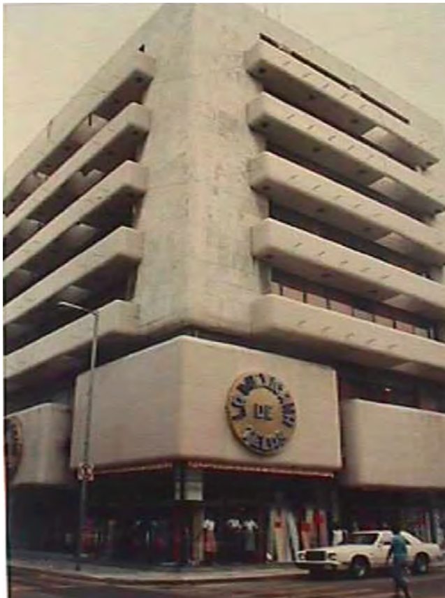
Fachada original donde se aprecian los parapetos de planta baja. Tomado de: https://centrohistorico.veracruzmunicipio.gob.mx/
