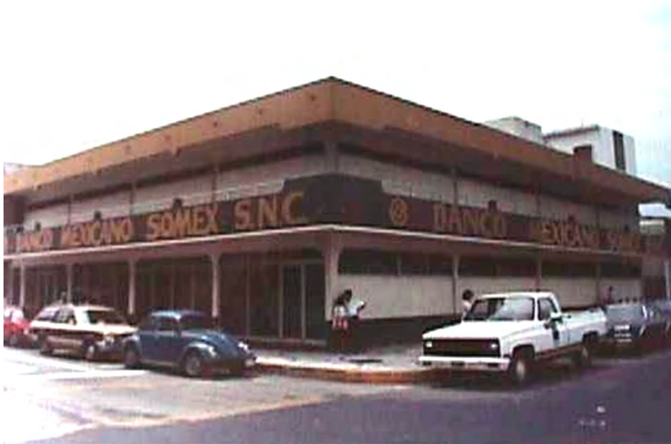
Fachada original. Tomada de: https://centrohistorico.veracruzmunipio.gob.mx/
