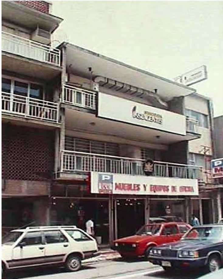
Fachada original. Tomada de: https://centrohistorico.veracruzmunipio.gob.mx/
