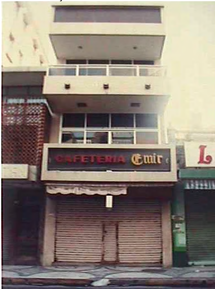
Fachada original con barandal de aluminio y acrílico ahumado. Tomado de: centrohistorico.veracruzmunipio.gob.mx/
