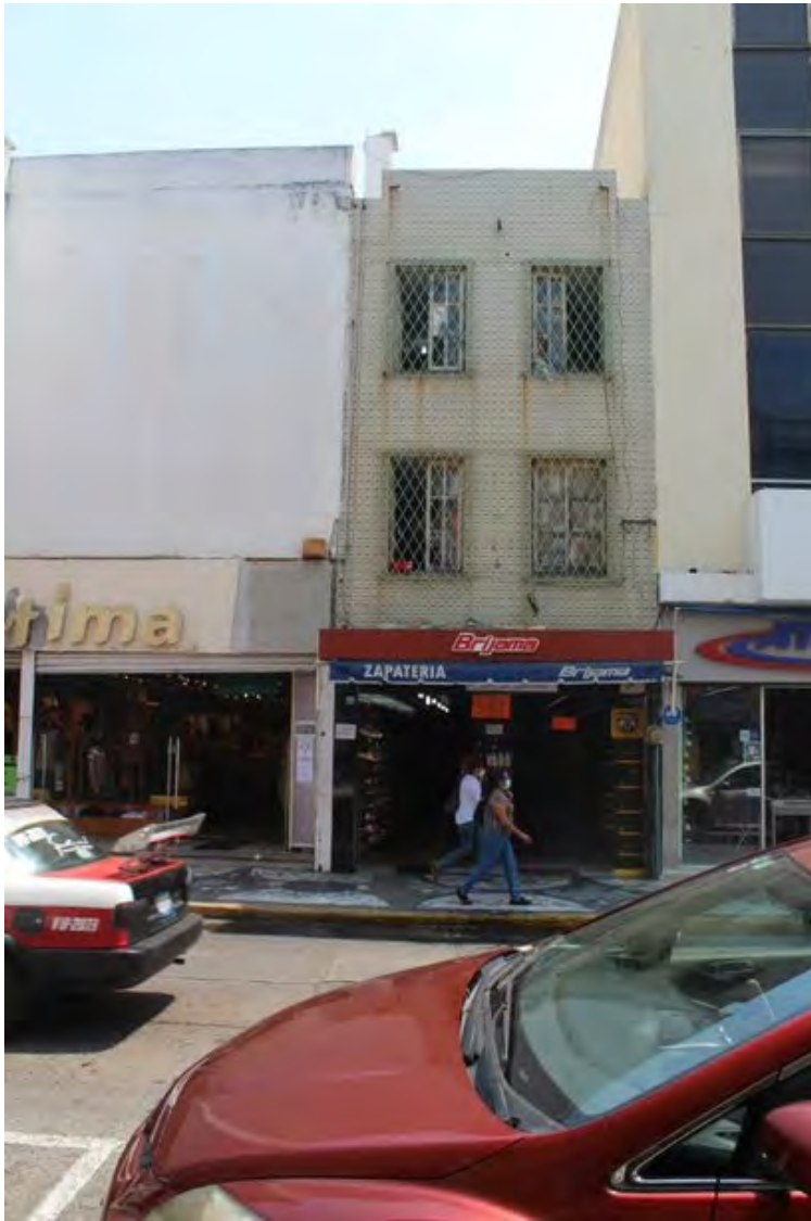
1. Fachada principal edificio Av. Independencia #1426
