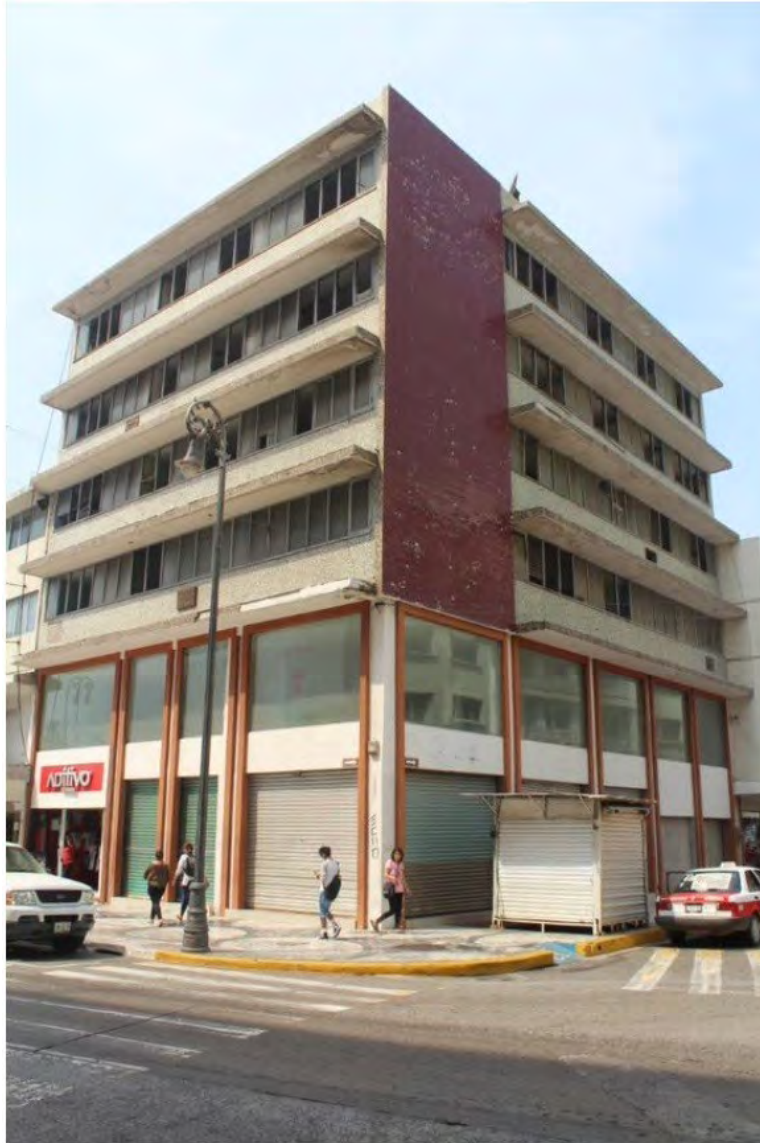
Fachada Principal, Av. Independencia #1691
