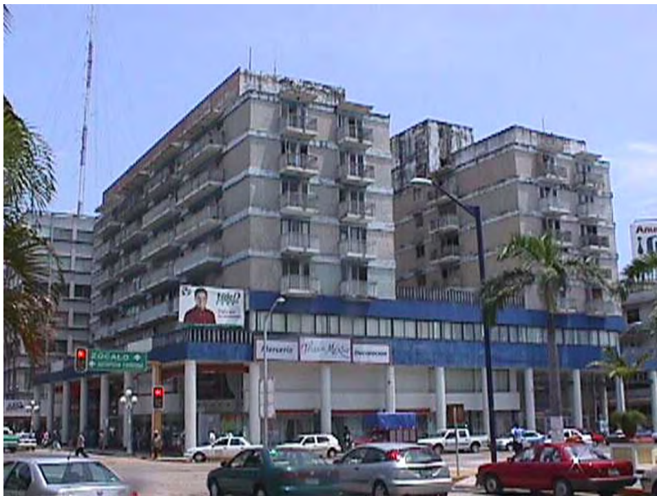
Hacia 2004. Aún se aprecian los balcones sobre calle Rayón. Tomado de: https://centrohistorico.veracruzmunipio.gob.mx/
