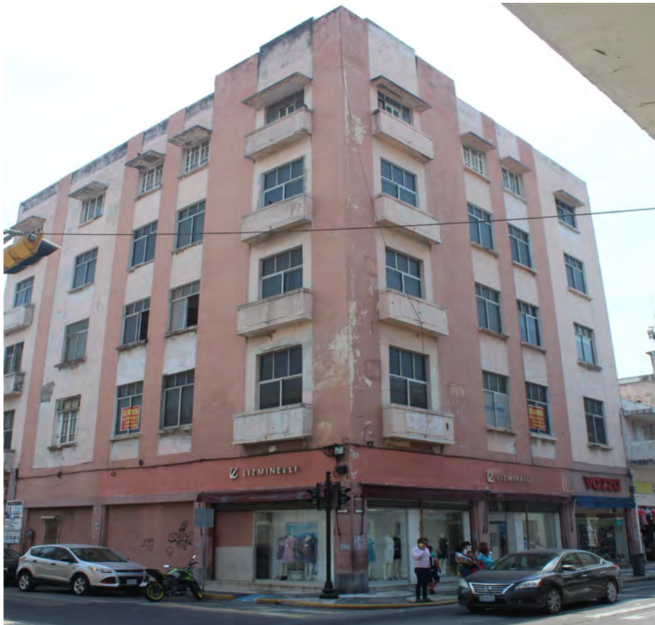
1. Fachada principal edificio Av. Independencia #1510
