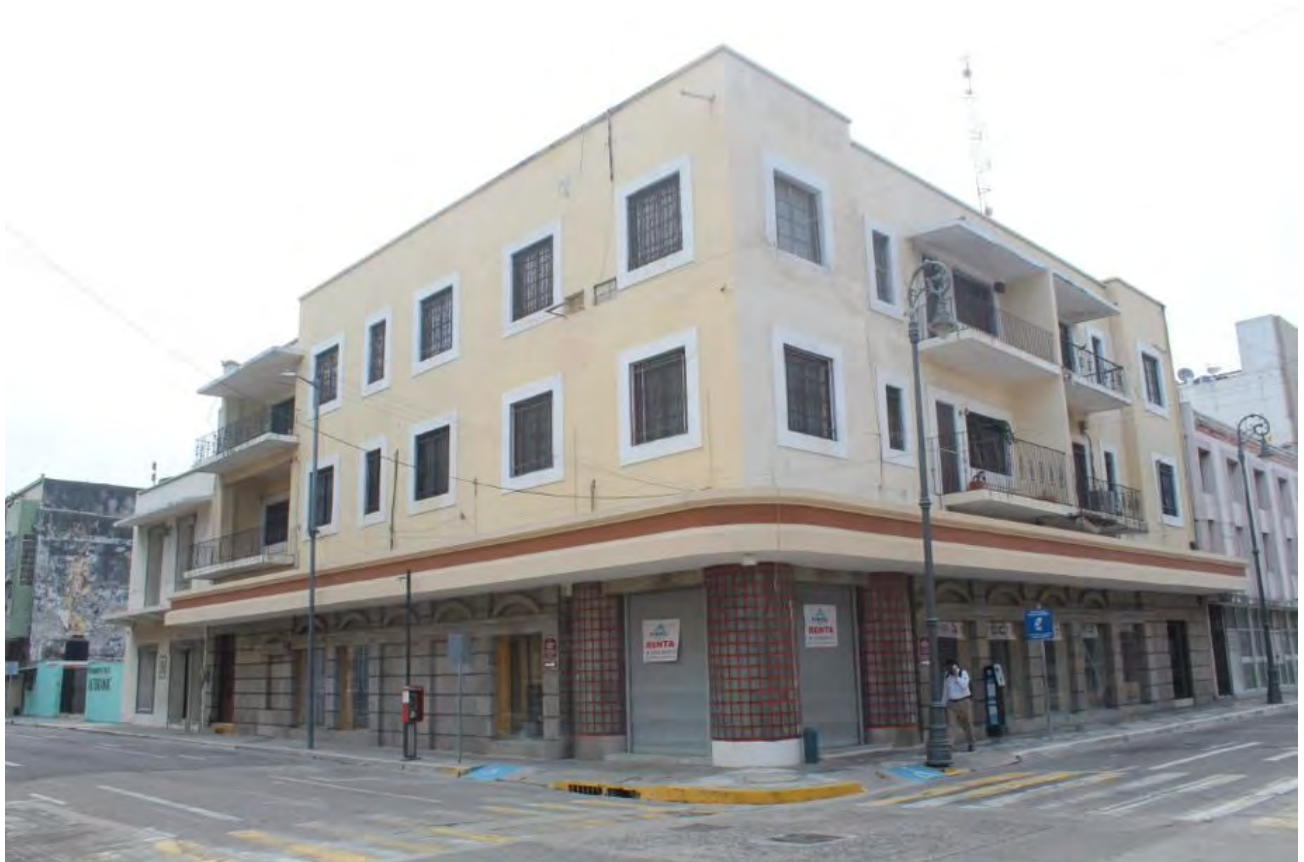
1. Fachada principal edificio Av. Independencia #900
