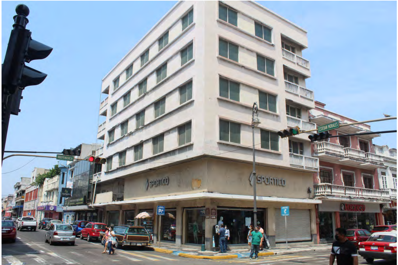
1 Fachada principal edificio Av. Independencia #1473
