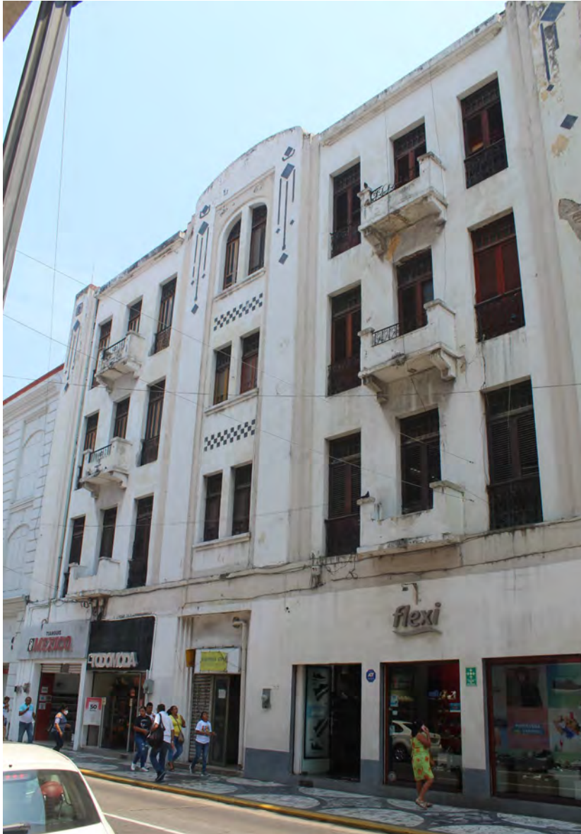
Fachada Principal, Av. Independencia #1348
