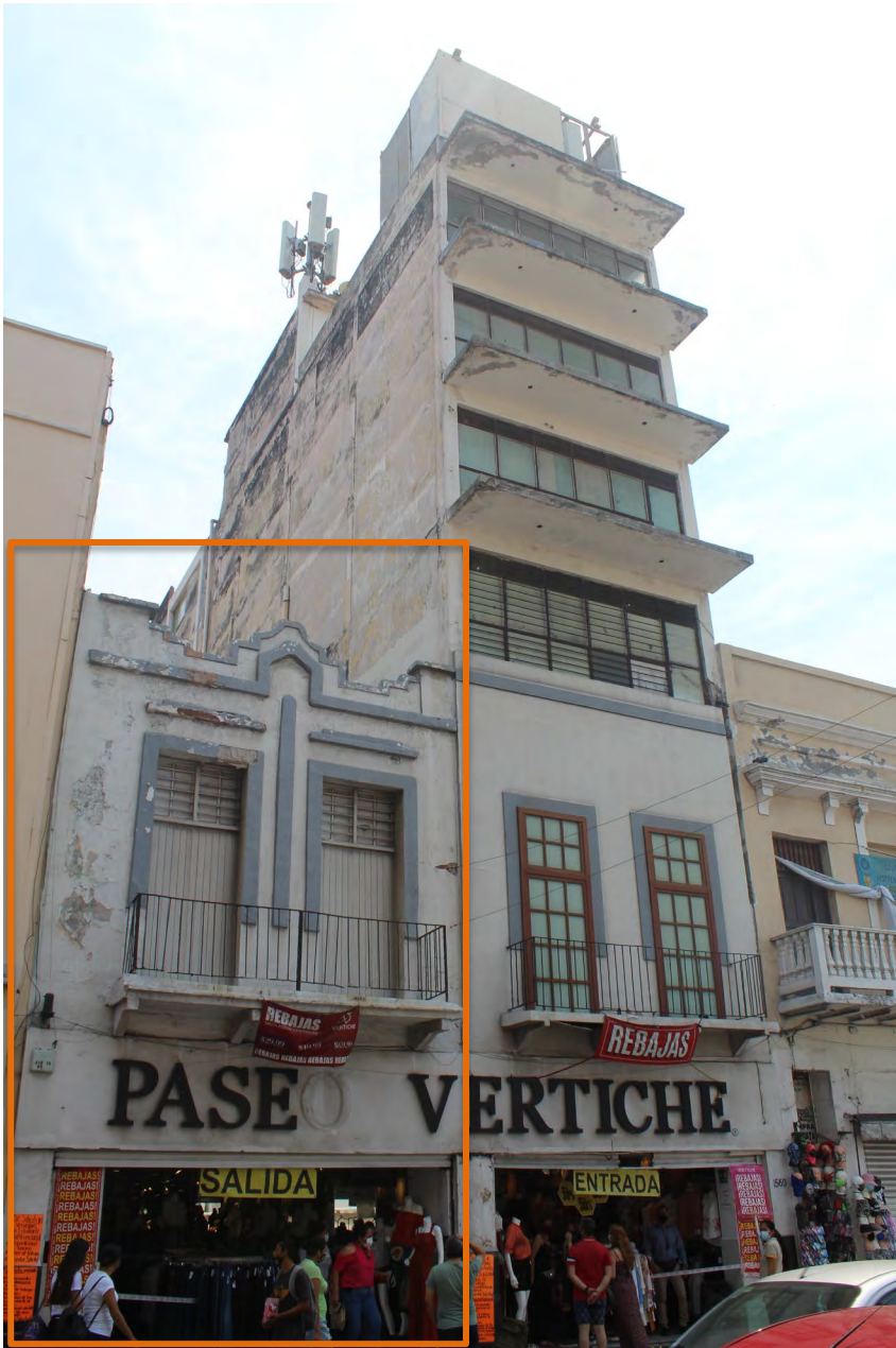
1 Fachada principal edificio Av. Independencia # 1560
