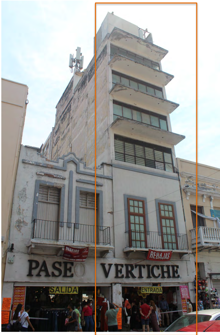
1 Fachada principal edificio Av. Independencia # 1560
