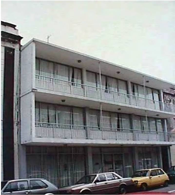
Fachada original con barandales en los balcones. Tomada de: https://centrohistorico.veracruzmunipio.gob.mx/
