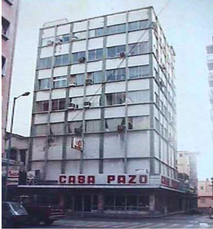
Aspecto original del edificio. (hacia 1940). Tomado de: Recordando mi viejo Veracruz (grupo de facebook)
