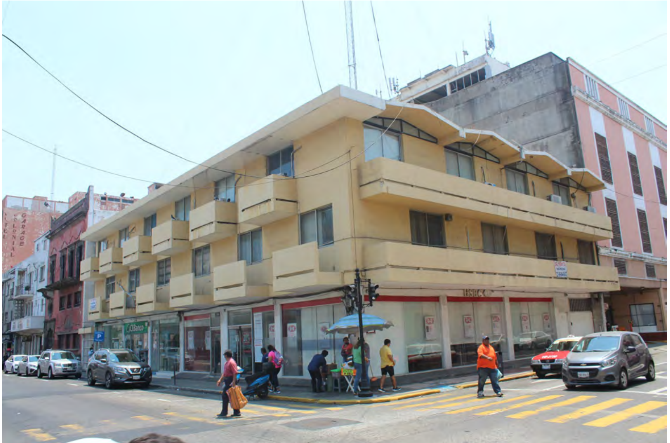
1. Fachada principal edificio Av. Independencia #1028
