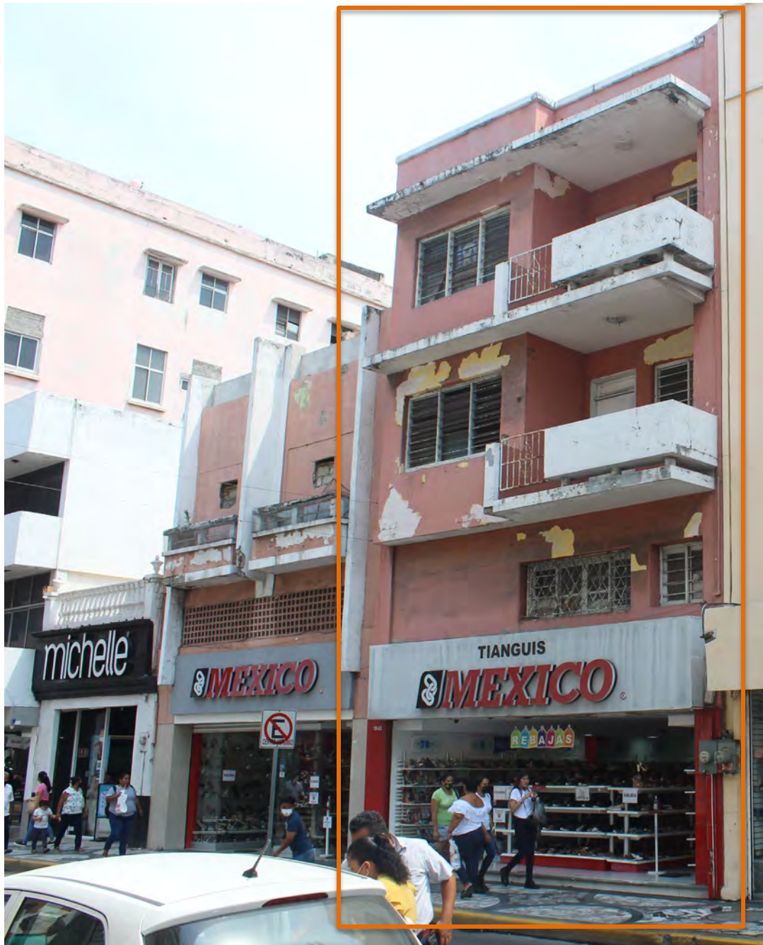
1 Fachada principal edificio Av. Independencia # 1560
