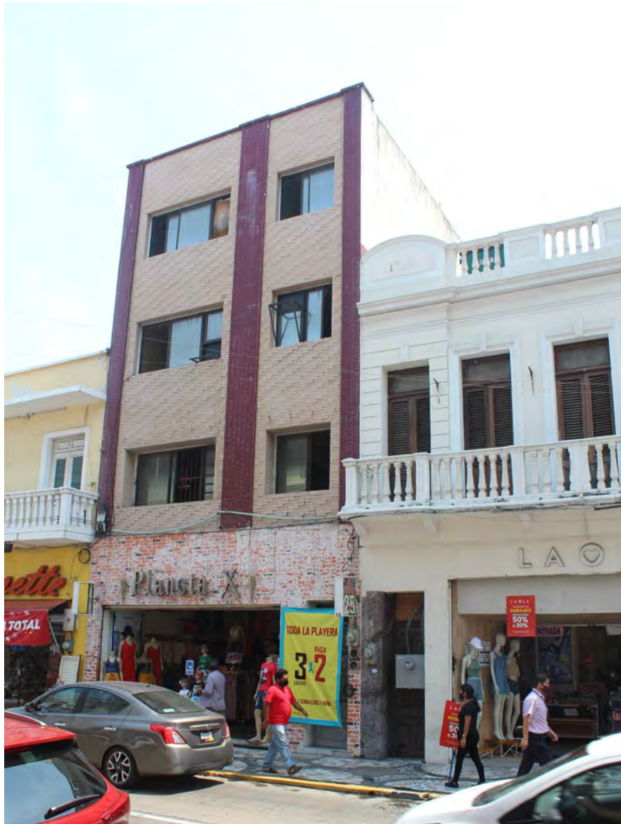
Fachada Principal, Av. Independencia #1460
