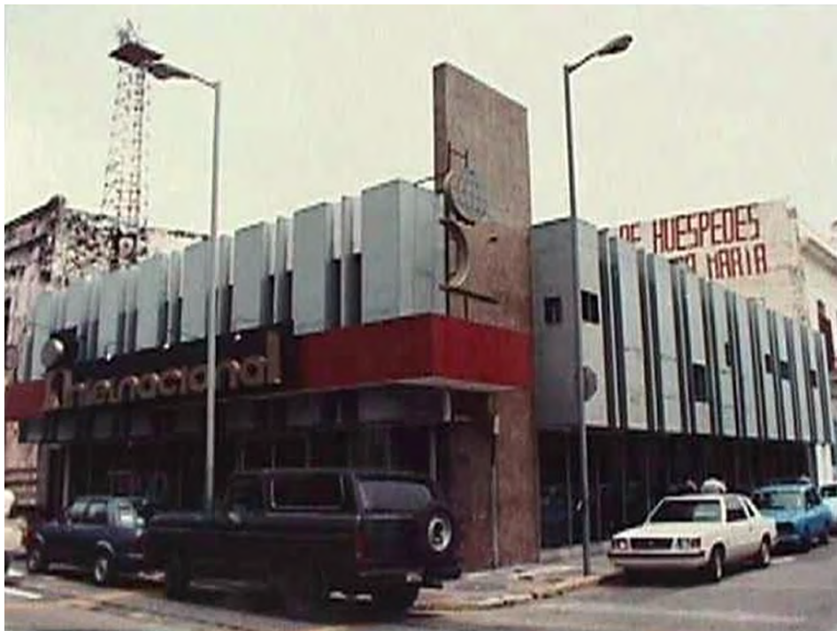
Fachada original con los parasoles de planta alta. Tomado de: https://centrohistorico.veracruzmunipio.gob.mx/
