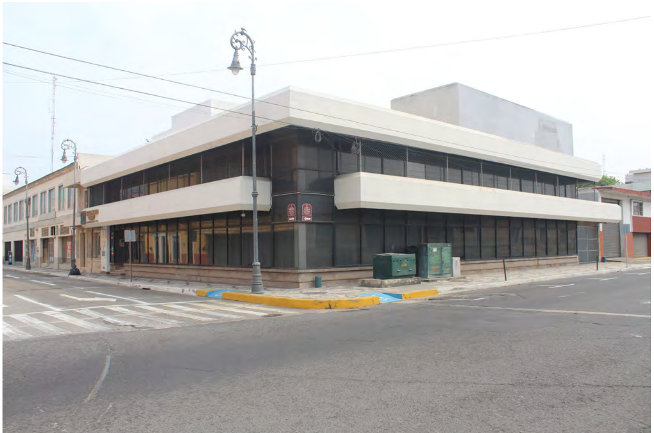
1 Fachada principal Edificio
