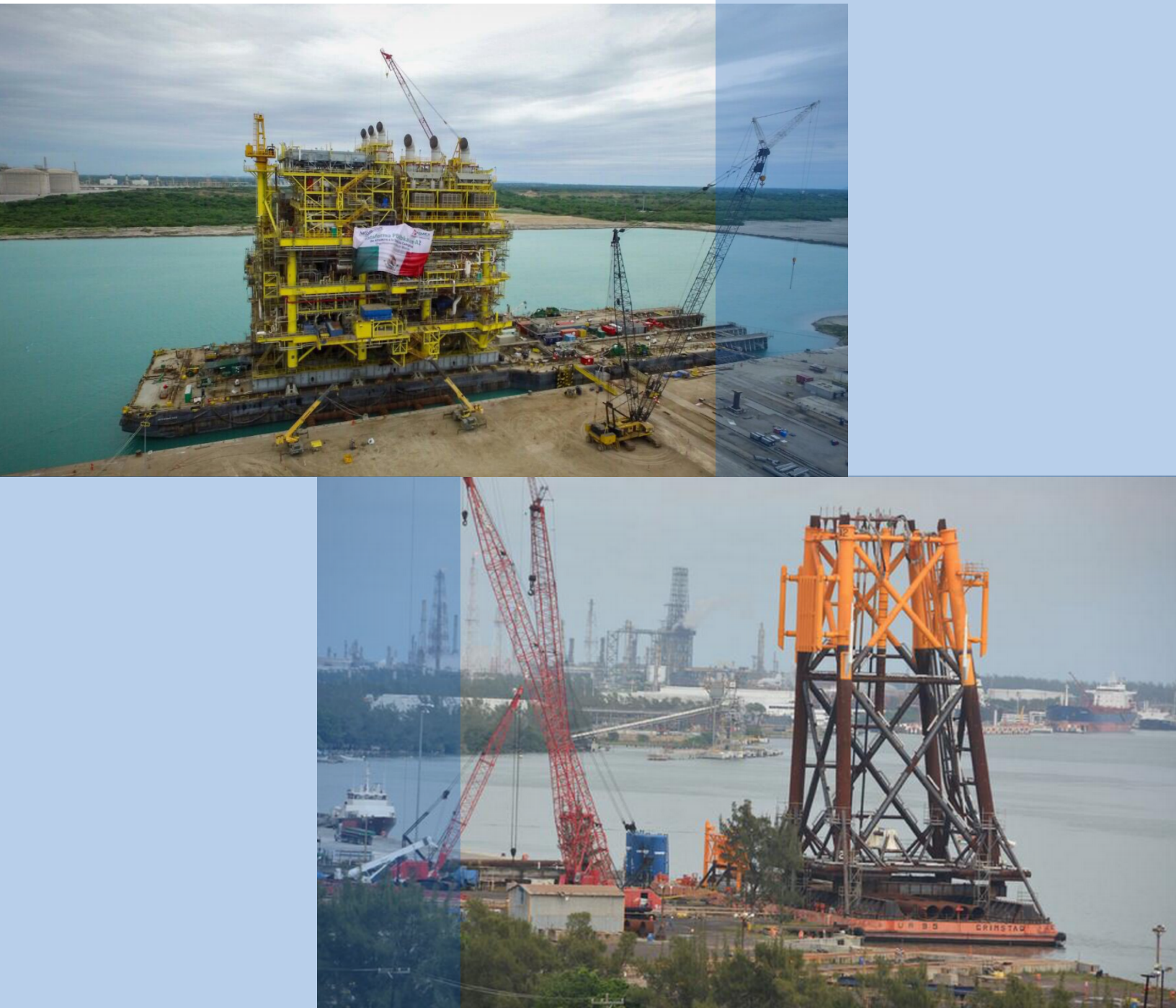
Figura 1. Construcción de una plataforma marina.[2]
