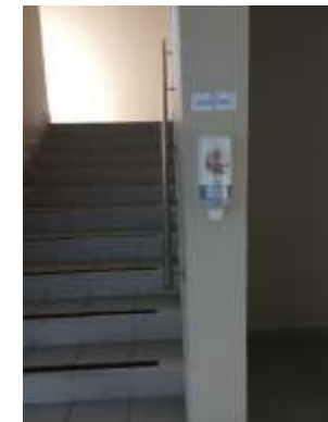
Instalación de barandales en escaleras
