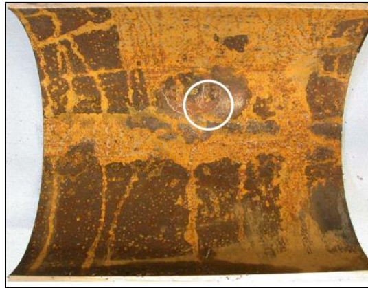
Figura 6. Falla ocasionada por oxígeno y H_2S
