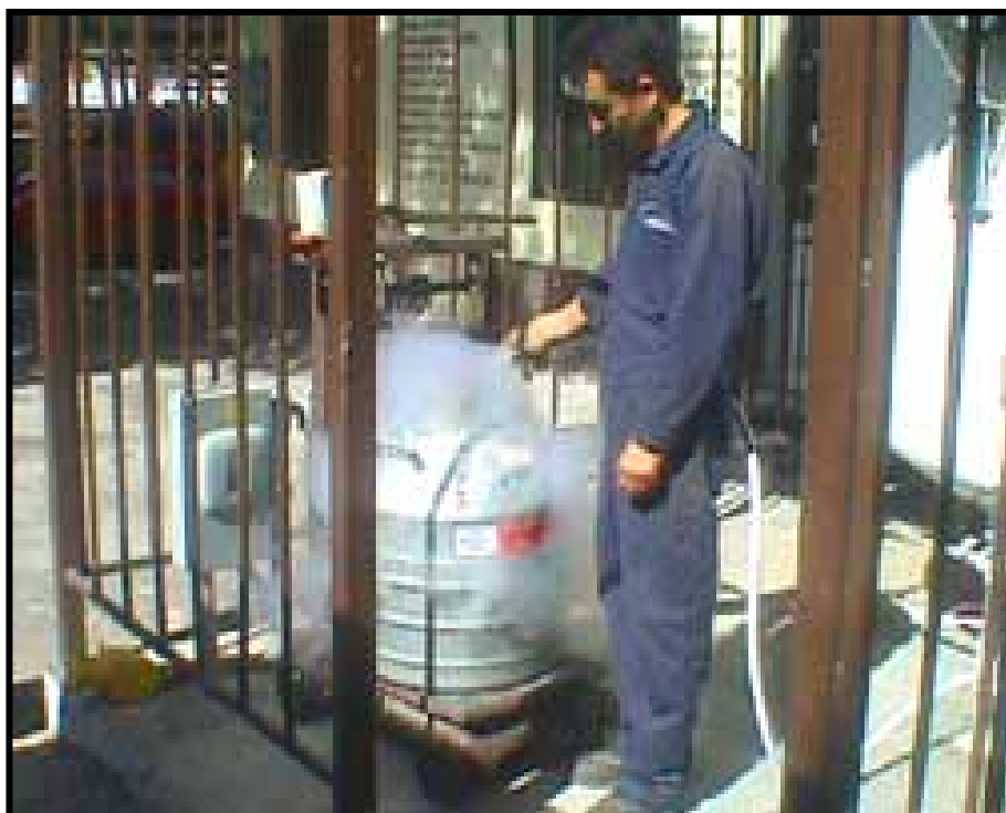
Fig. N°10 TRASIEGO DEL NITRÓGENO LIQUIDO
