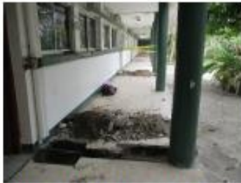
Reparación de bajantes pluviales Edificio C
