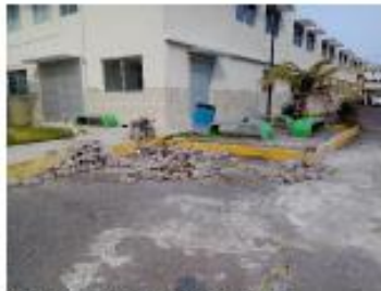
Limpieza general de toda la zona
