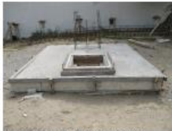
Cisterna Edificio J (en construcción)
