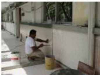
Colocación de lambrín en muro Edificio C
