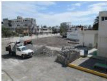
Estacionamiento FIMCN (en construcción)
