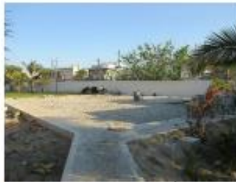
Estacionamiento (en construcción)
