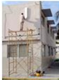
Colocación de Letra J
