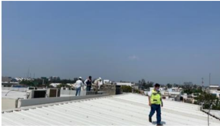
Ilustración 87 Inspección de Cubierta de Azotea, Facultad de Psicología
