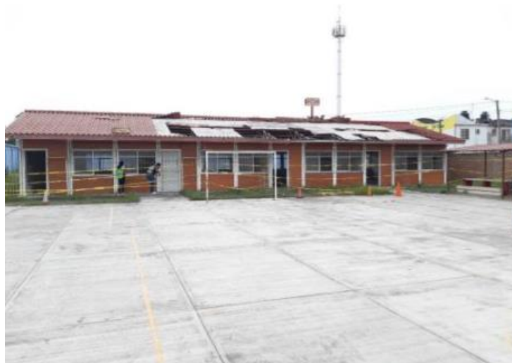
Ilustración 88 Inspección de Aulas en Esc. Prim. Dr. Gonzalo Aguirre Beltrán
