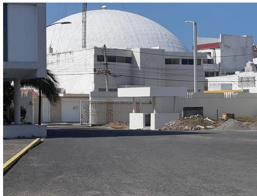
Figura 68 Evidencia construcción de casetas de acceso a la Unidad de Ingenierías
