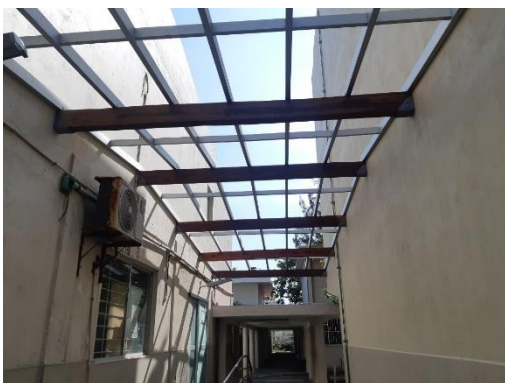
Figura 69 evidencia rehabilitación pasillo biblioteca
