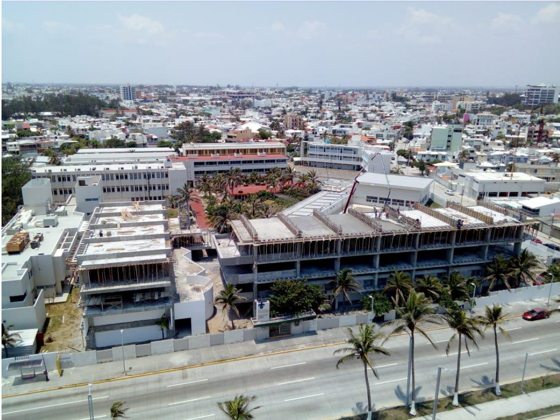
Fig. 25 Vista aérea de la reconstrucción de los edificios A y B
