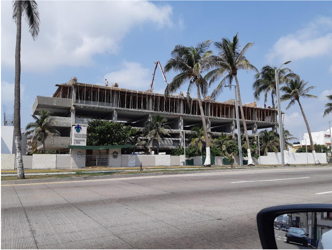
Fig. 27 Vista de la calle d la Reconstrucción del edificio A
