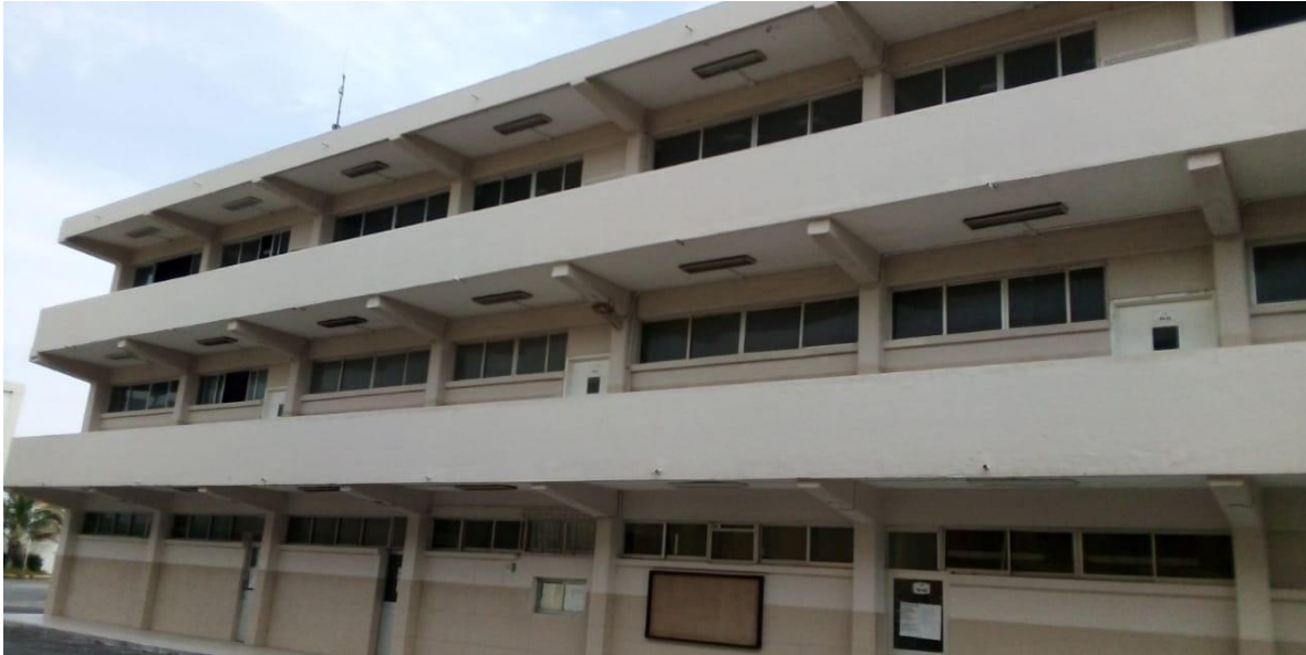
Fig. 23 Vista del edificio H rehabilitado
