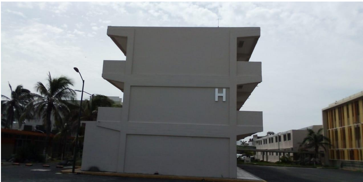
Fig. 22 Edificio H después de la rehabilitación
