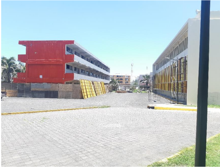
Fig. 21 Rehabilitación de Edificio H (Ingeniería Civil)
