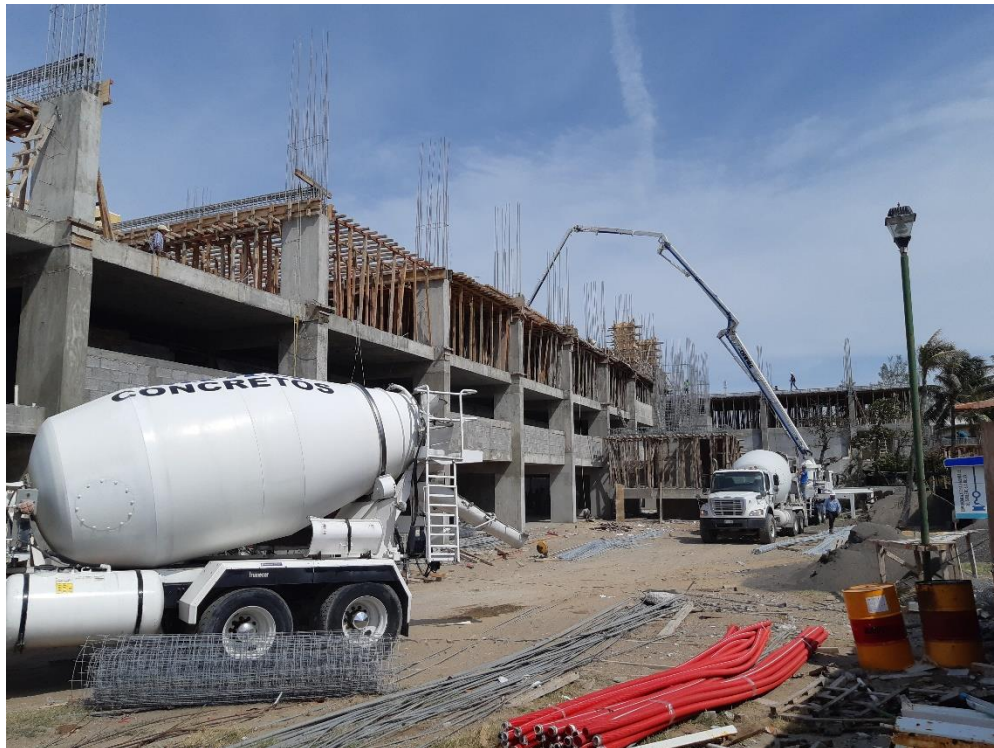
Fig. 24 Reconstrucción de Edificios A y B (Oficinas administrativas y Aula Magna)
