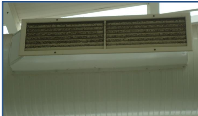
Fig. 10. Rejilla de succión con acumulación de polvo.
