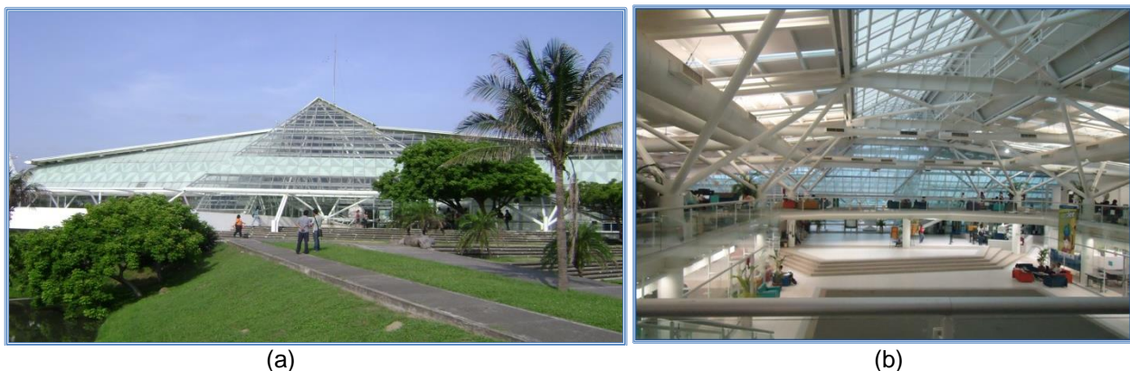
Fig. 17. (a) Fachada principal de la USBI, en donde se aprecia como el sol cubre por completo y todo el día sus paredes este, el techo y la pared oeste. (b) Vista interior del techo y paredes de cristal por donde entra la radiación solar
