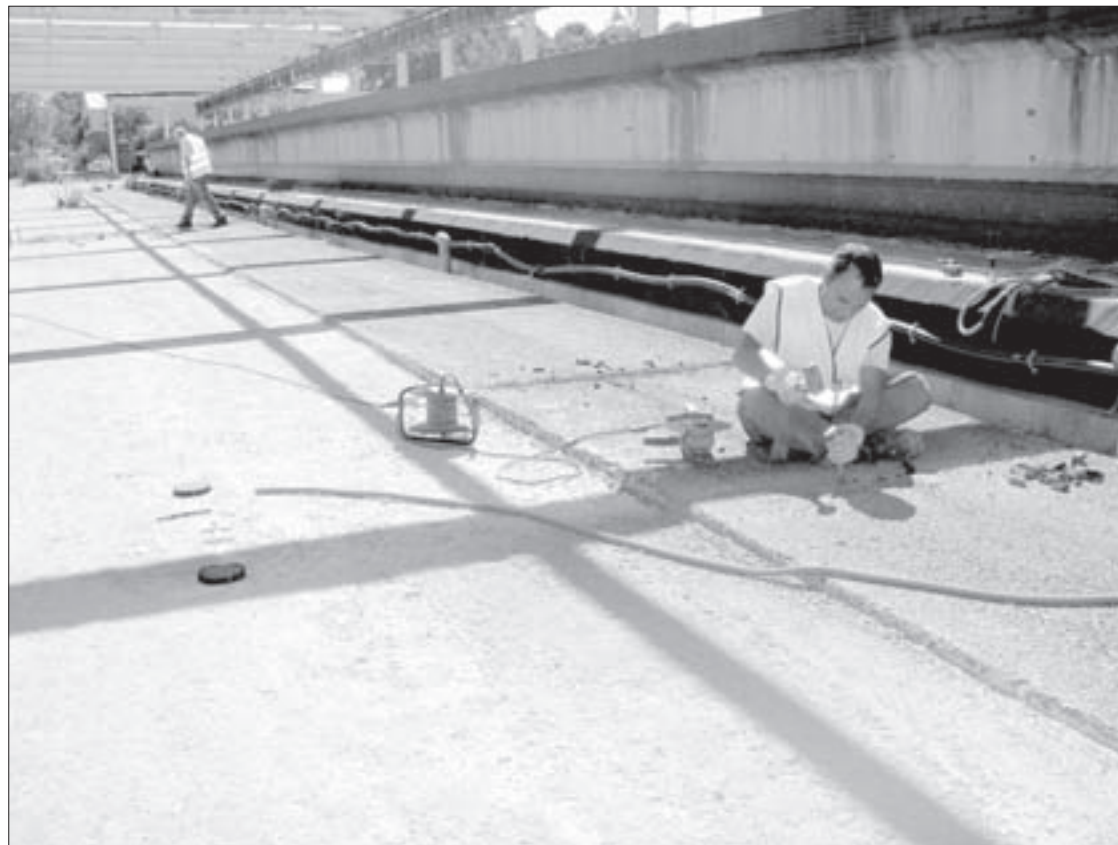
Proceso de colocación de sensores en la pista
