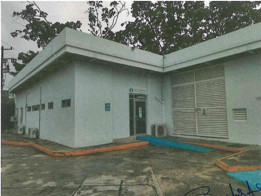
Edificio F módulo SAISUV
