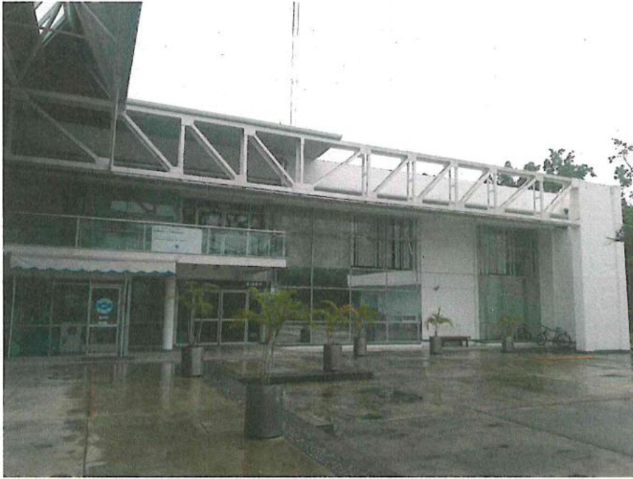
Edificio C de Centro de Idiomas
