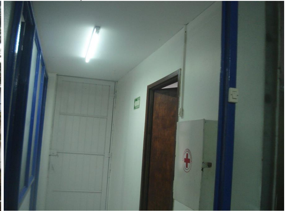
Aplicación de pintura interior y exterior y cambio de piso Edificio “A”
