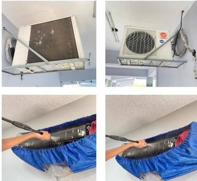
Ilustración 4. Mantenimiento de aire acondicionado
