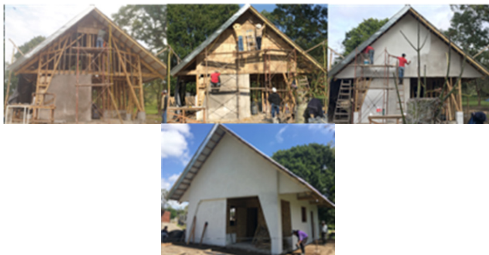
Figura 11. Estructura de muros, recubrimiento con esterilla y aplanado.
