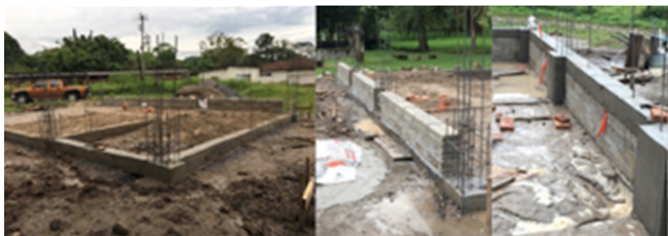
Figura 7. Proceso constructivo de cimentación, armados y tipos de anclaje.
