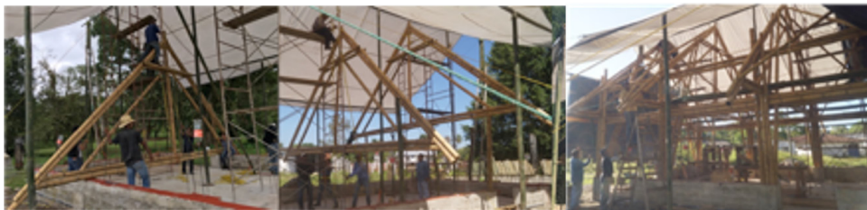
Figura 9. Rigidización de las armaduras y colocación de riostras longitudinales.
