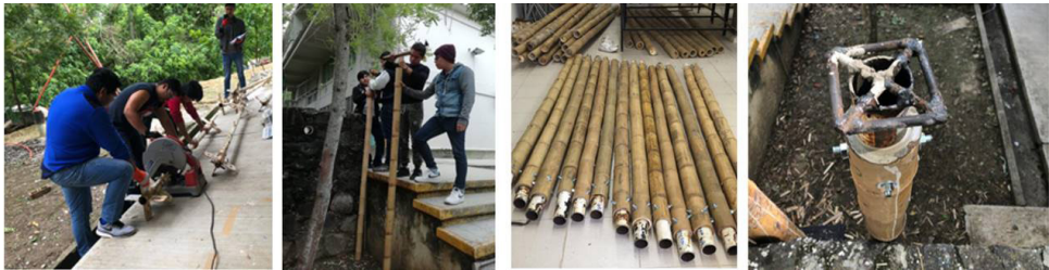
Figuras 14-17. Construcción de las barras de bambú
