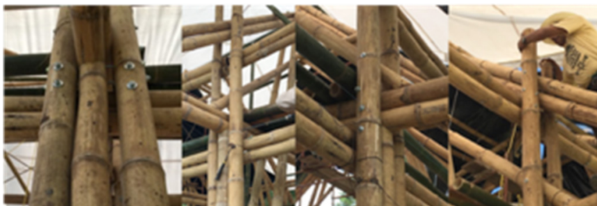
Figura 10. Uniones al poste vertical con cuerdas inferiores, riostras longitudinales y cuerdas superiores.
