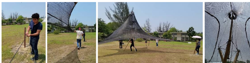
Figuras 39-42. Armado de la cubierta con el módulo prismático triangular
