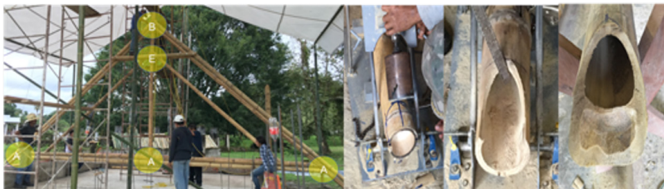
Figura 8. Armadura, uniones y elementos componentes. Tipos de cortes utilizados en las uniones.
