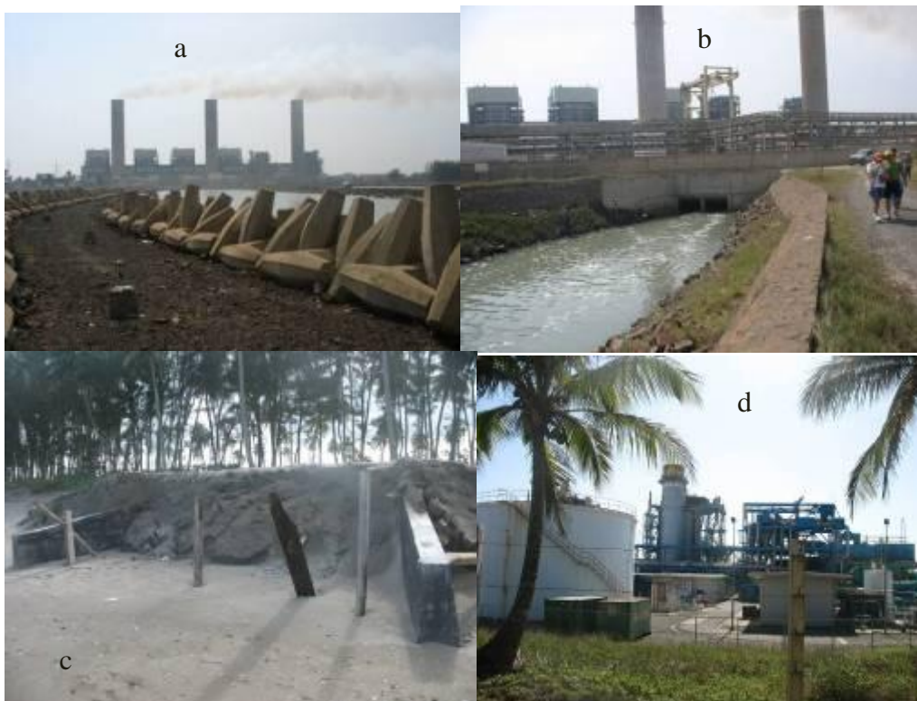
Figura 6.- Central termoeléctrica Adolfo López Mateos en la Playa Norte. a y b) Central Termoeléctrica Chile frío en la playa del Sur del Municipio Tuxpan-Veracruz. c y d)
