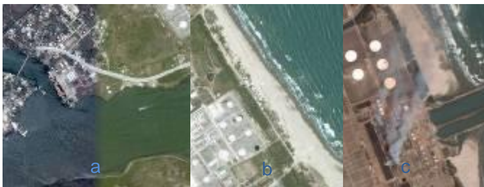
Figura 2.- Instalaciones Portuarias (a), petroleras (b) y termoeléctrica (c) en la desembocadura del río Tuxpan. (Fotografías obtenidas de Google earth 2009).
