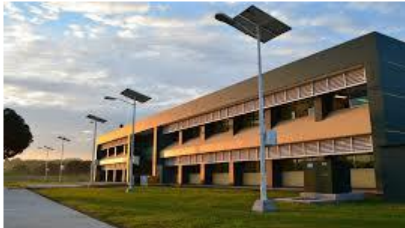
Imagen 2.1. Instalaciones actuales del ITSPR
