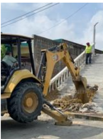
Figura 129. Imágenes de los trabajos para obtener muestra de suelo en Coatzintla
