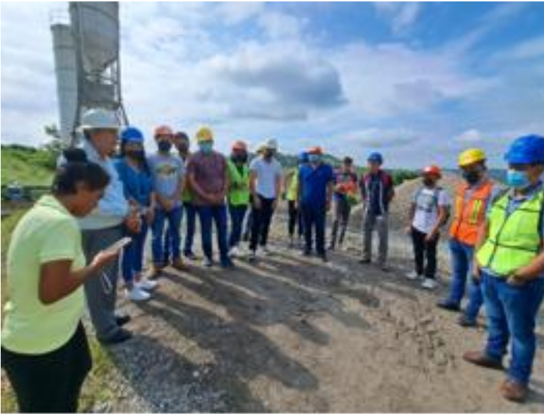
Figura 126. Explicación en concretera
