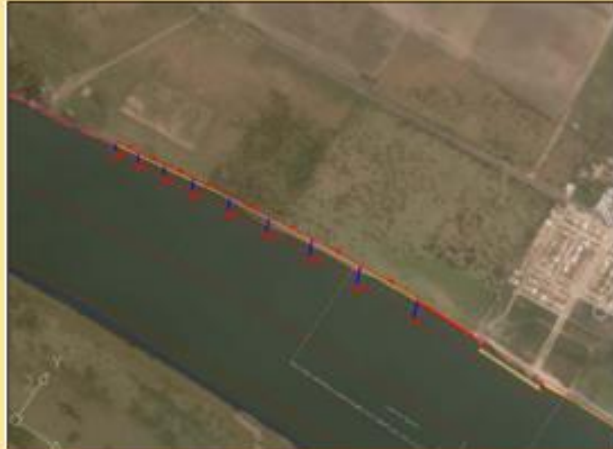
Ilustración 1 espigones y protección marginal
