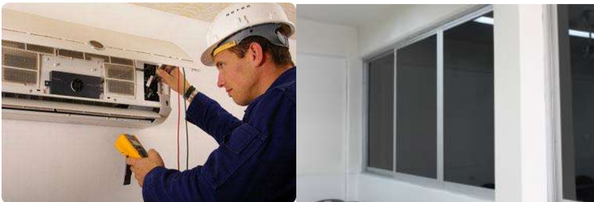
MANTENIMIENTO PERMANENTE EN CLIMAS Y VIDRIOS DE LAS AULAS YA POLARIZADOS
