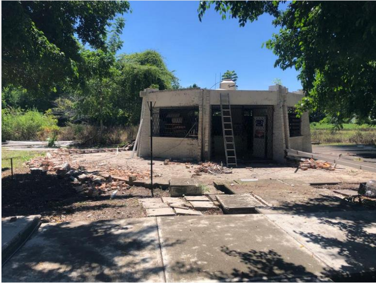
Inicio de la construcción de la cafetería
