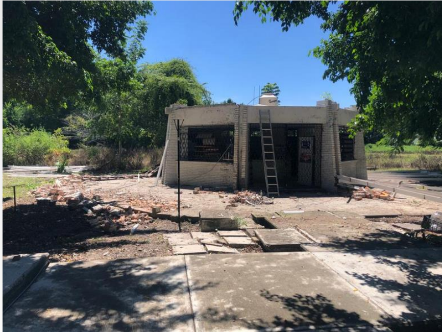
Inicio de la construcción de la cafetería
