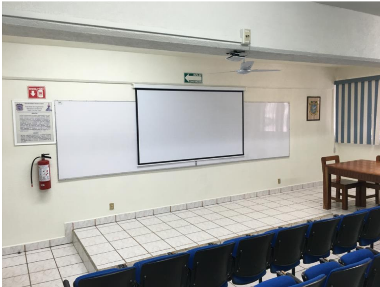
Instalación de pantallas
