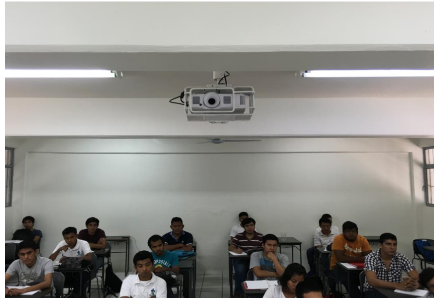
Instalación de proyectores
