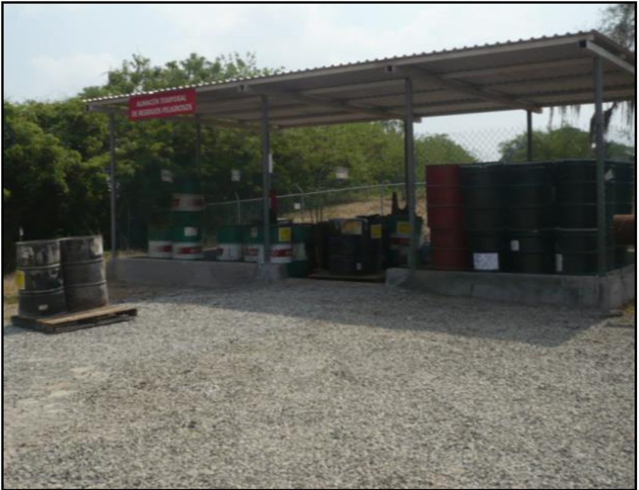
Figura 9. Almacén Temporal de Residuos Peligrosos.
