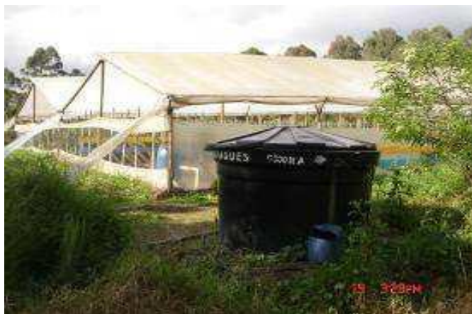
Figura 12. Tanque de reserva de agua
