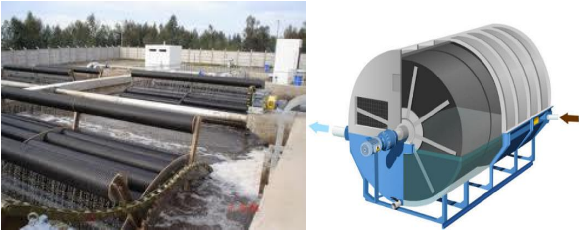
Figura 15. Tratamiento a base de biodiscos.
