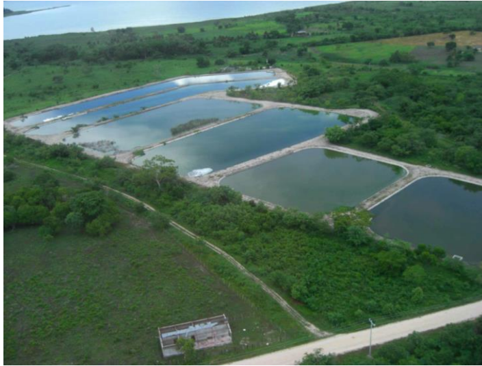
Figura 21. Lagunas de maduración.
