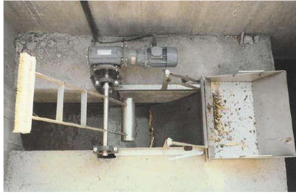
Figura 6. Reja de desbaste circular (limpieza cepillo).
