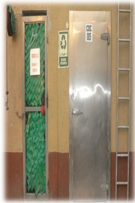
Almacén para desechos orgánicos
