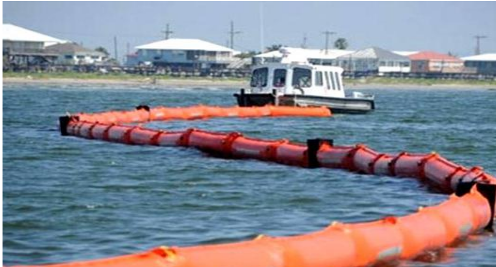
Figura 5.-Barrera de trampa para contención de hidrocarburos, se observa el área que sobresale del nivel de agua. Fuente: NOAA, 2011.
