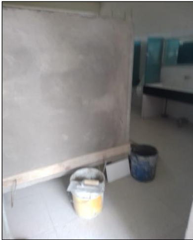
Fabricación de mampara en material de construcción para baño de hombres edificio B.
