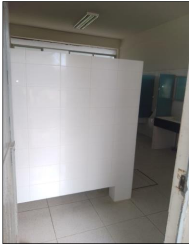
Fabricación de mampara en material de construcción para baño de hombres edificio B.
