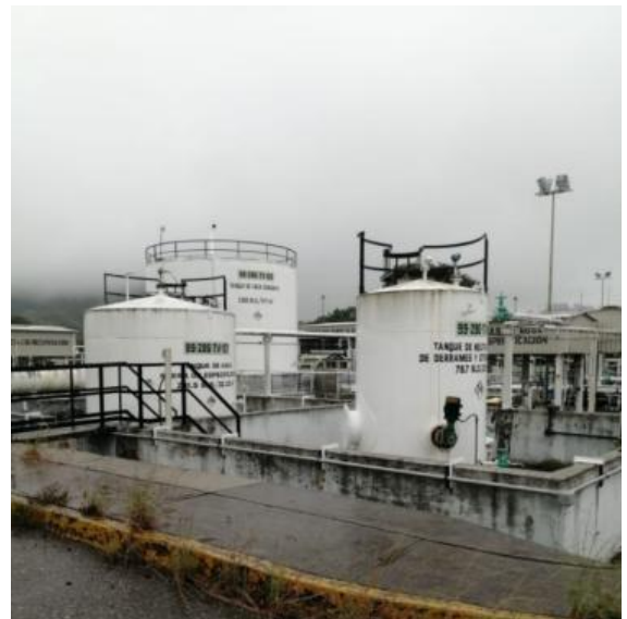
Se explico la capacidad de los contenedores y que presión se trabajan siendo esta la constante de operación ya sea para una capacidad de 3000 bls hasta 10000
