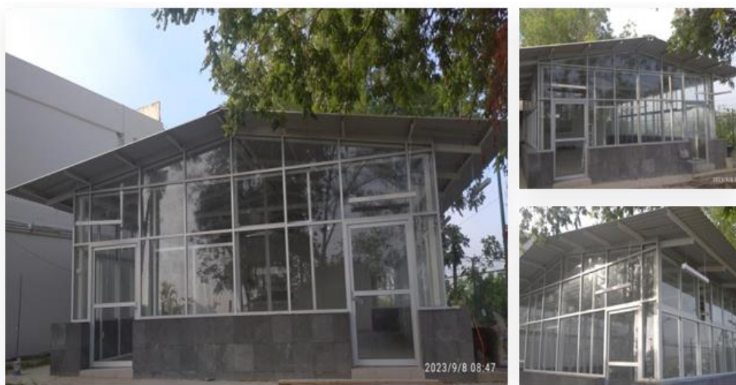
Figura 46. Construcción del Comedor Universitario en apoyo a los hábitos de alimentación sana.
