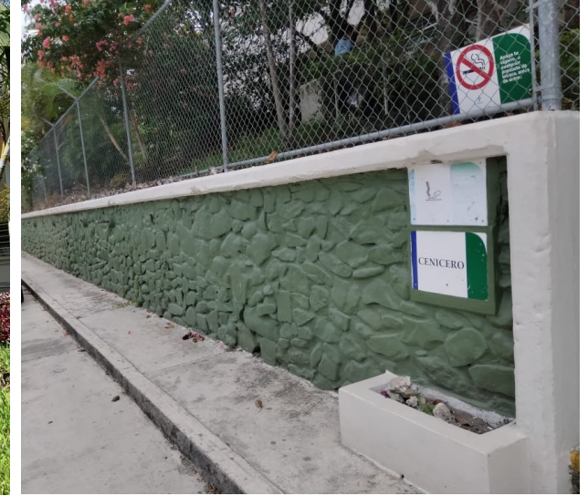
Trabajos de pintura en barda frontal.
