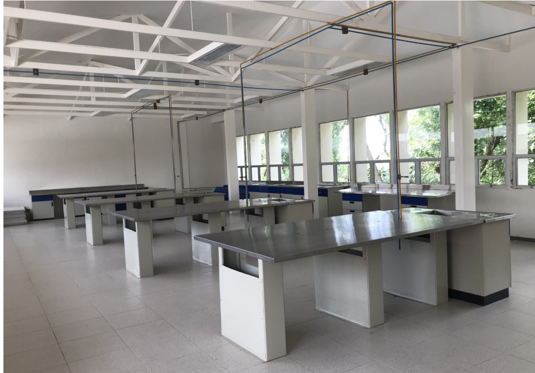
Remodelación de laboratorio de B. Marina.
