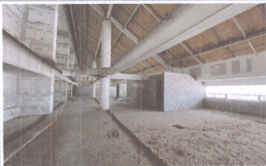
F1: Vista interior área técnico-académica y administrativa
