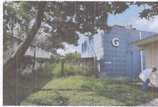
F2: Vista exterior Edificio G
