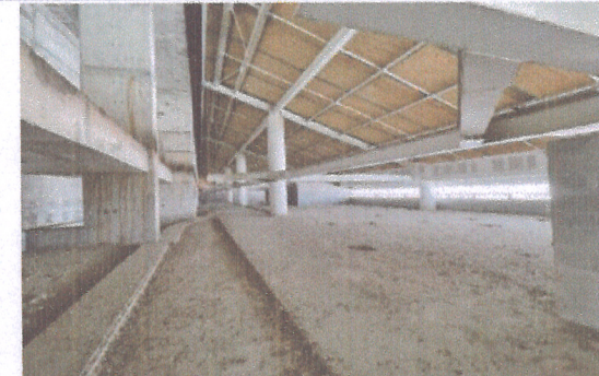
F2: Vista interior área técnico-académica y administrativa
