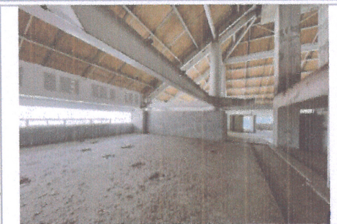
F3: Vista interior área técnico-académica y administrativa
