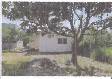
F3: Vista exterior Edificio I y J
