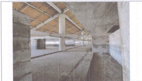
F4: Vista interior área técnico-académica y administrativa
