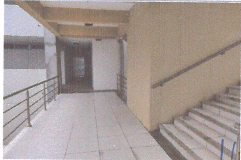
F3: ESCALERAS SEGUNDO NIVEL
