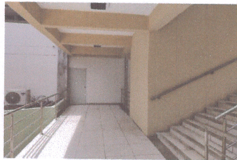
F2: ESCALERAS PRIMER NIVEL
