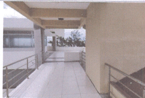
F4: ESCALERAS TERCER NIVEL
