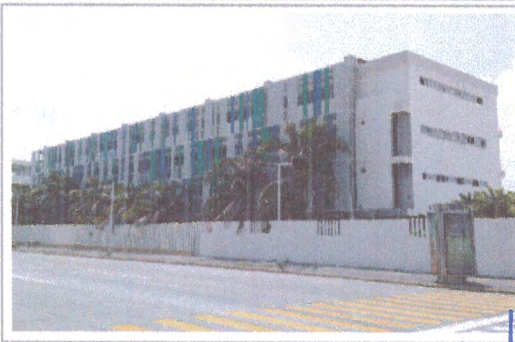
F3: FACHADA EDIFICIO A
