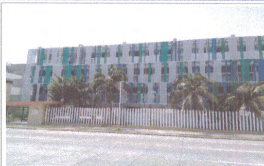
F2: FACHADA EDIFICIO A
