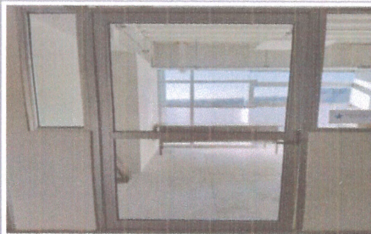
F2: Cubículos último nivel Edificio B
