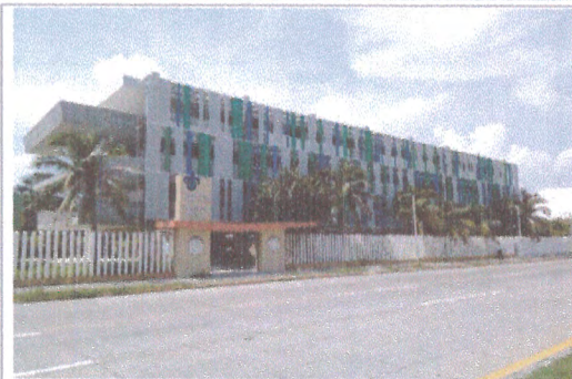
F1: FACHADA EDIFICIO A
