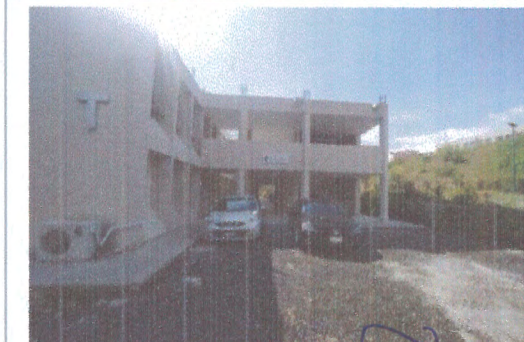
F5: Fachada lateral derecha
