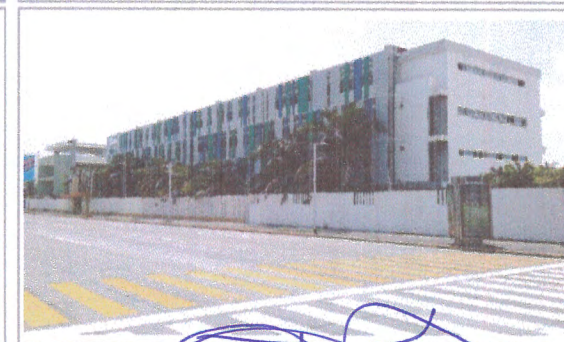
FOTO 5: FACHADA EDIFICIO A
