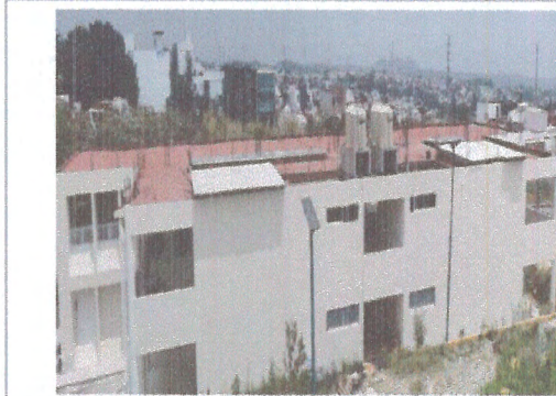
F2: Fachada lateral izquierda
