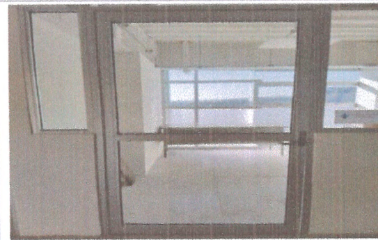
F2: Cubículos último nivel Edificio B
