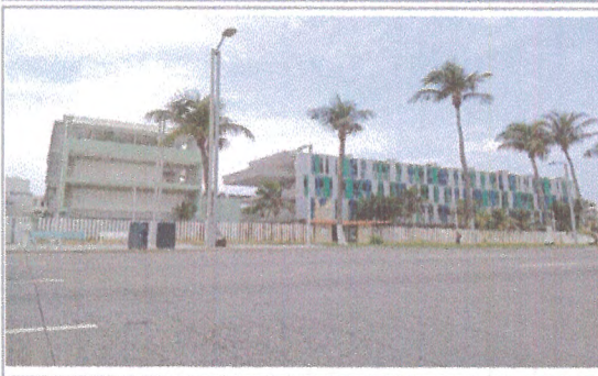
F4: FACHADA EDIFICIO A
