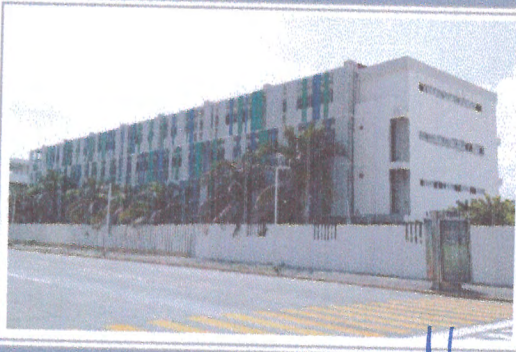
F3: FACHADA EDIFICIO A
