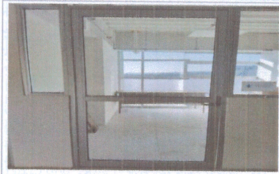
F2: Cubículos ultimo nivel Edificio B
