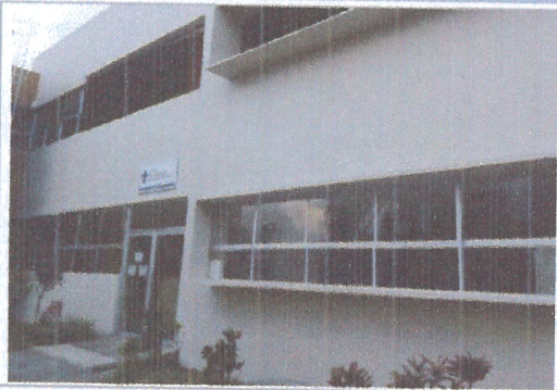
F1: Fachada principal
