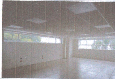
F4: Vista general, primer nivel Posgrados
