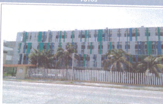
F2: FACHADA EDIFICIO A
