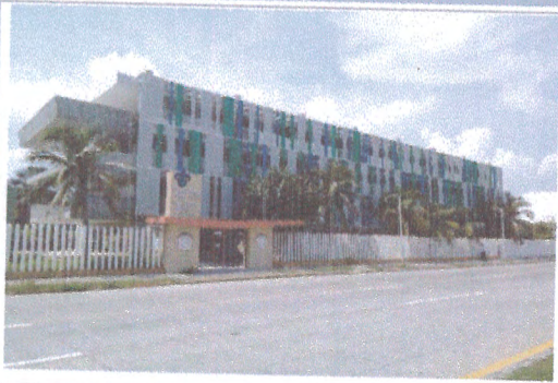
F1: FACHADA EDIFICIO A
