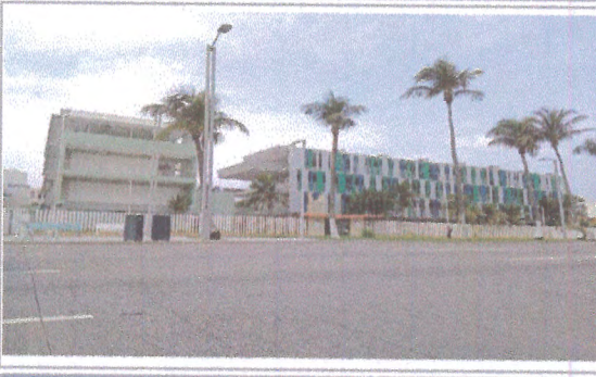
F4: FACHADA EDIFICIO A
