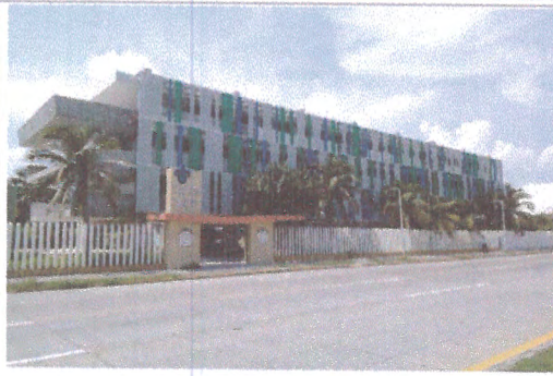
F1: FACHADA EDIFICIO A
