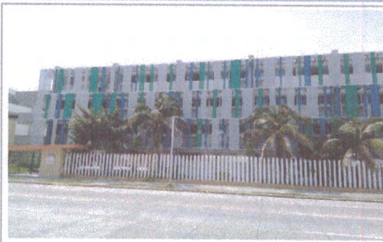
F2: FACHADA EDIFICIO A
