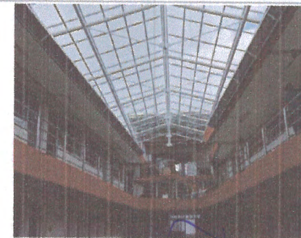
F5: Vista desde planta baja
