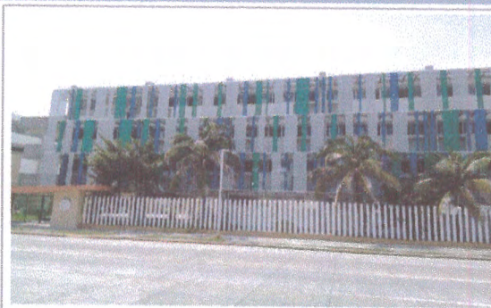
F2: FACHADA EDIFICIO A
