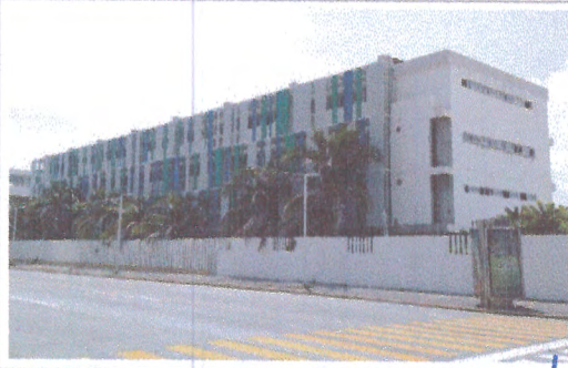
F3: FACHADA EDIFICIO A
