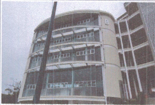
F1: Edificio A y E: Fachada Posterior
