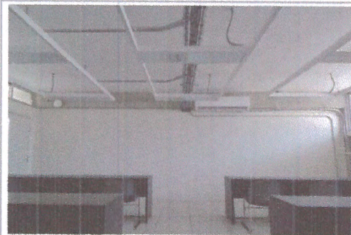
F1: Vista del interior de un aula terminada en el segundo nivel
