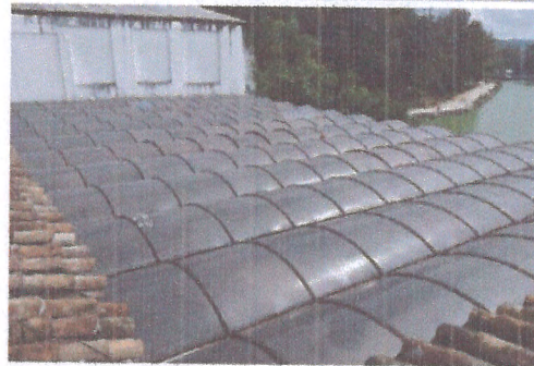
F4: Estado actual cubierta foro abierto
