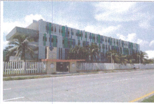
F1: FACHADA EDIFICIO A
