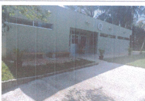
F4: Vista lateral exterior
