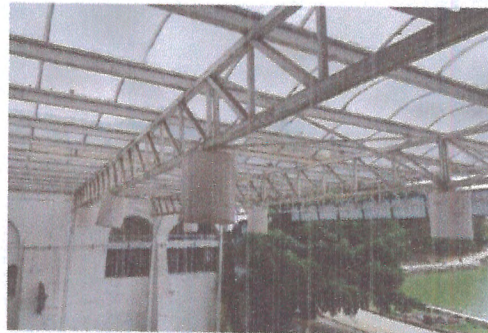
F2: Estado actual de la estructura
