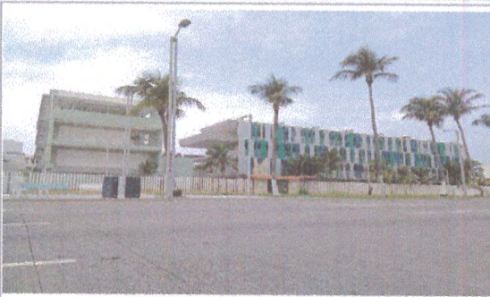
F4: FACHADA EDIFICIO A
