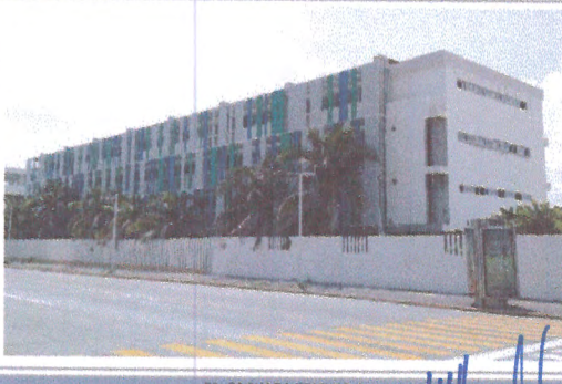
F3: FACHADA EDIFICIO A
