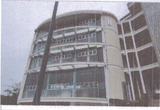
F1: Edificio A y B: Fachada Posterior
