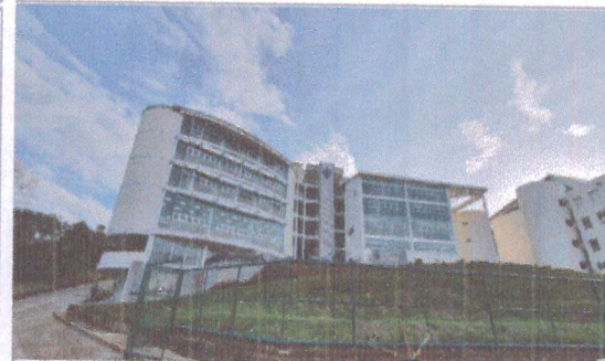
F5: Edificio C: Fachada Posterior
