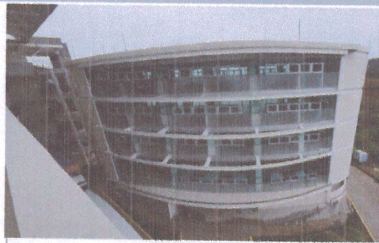
F2: Edificio A: Fachada Interior
