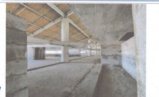
F4: Vista interior área técnico-académica y administrativa
