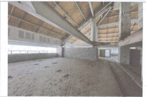
F3: Vista interior área técnico-académica y administrativa
