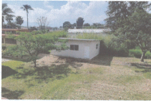
F1: Vista exterior Edificio I
