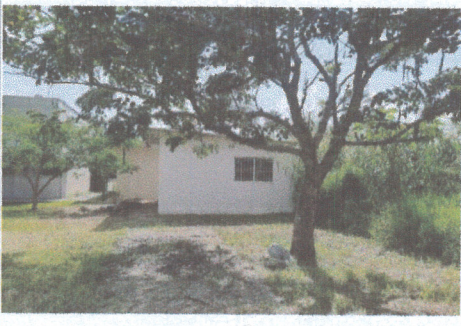
F3: Vista exterior Edificio I y J
