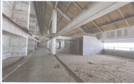
F1: Vista interior área técnico-académica y administrativa
