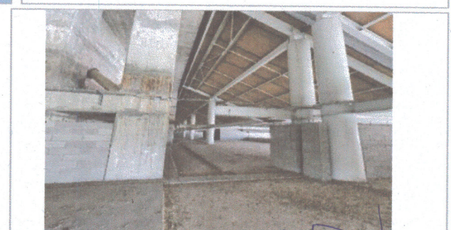
F5: Vista interior área técnico-académica y administrativa
