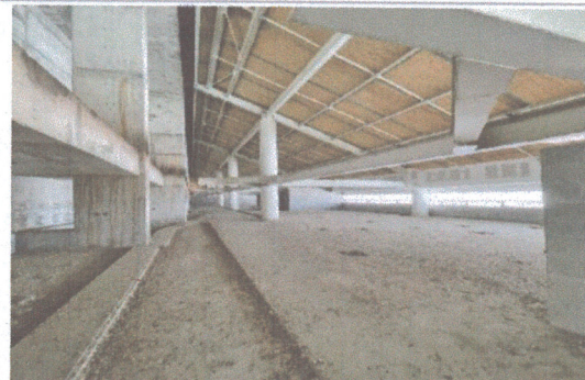
F2: Vista interior área técnico-académica y administrativa
