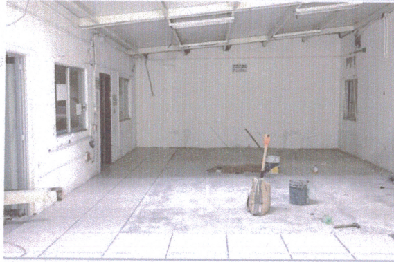
F2: Fotografía tomada desde el interior de la biblioteca donde se observa la cubierta ya colocada, así como la colocación del piso cerámico en la misma área.
