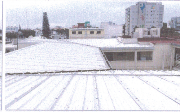
F8: Cubierta multipanel ya reparada y colocada vista desde la cubierta misma.
