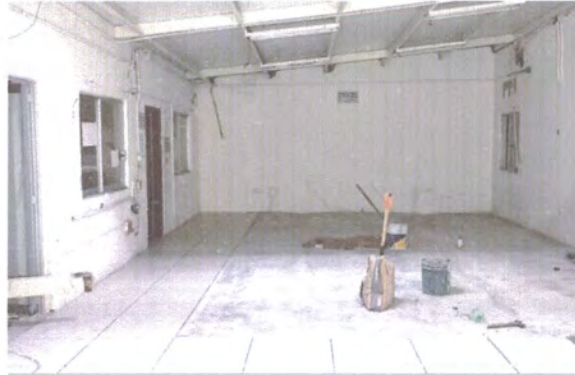
F2: Fotografía tomada desde el interior de la biblioteca donde se observa la cubierta ya colocada, así como la colocación del piso cerámico en la misma área.
