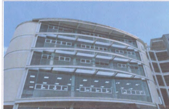
F2: EDIFICIO B VISTA DE FRENTE
