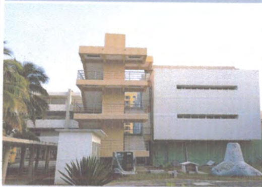
F1: ESCALERAS DEL EDIFICIO "B"
