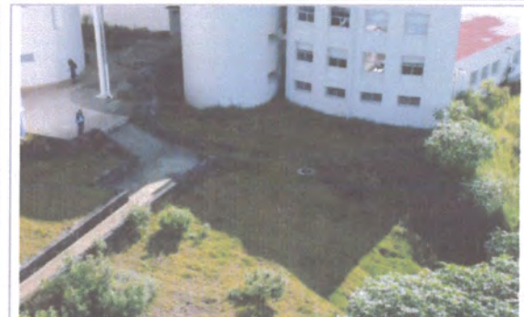
F5: VISTA DE ÁREA DE CISTERNA PLUVIAL
