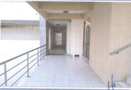
F3: TARJA VISTA DE LADO EN EL SEGUNDO NIVEL
