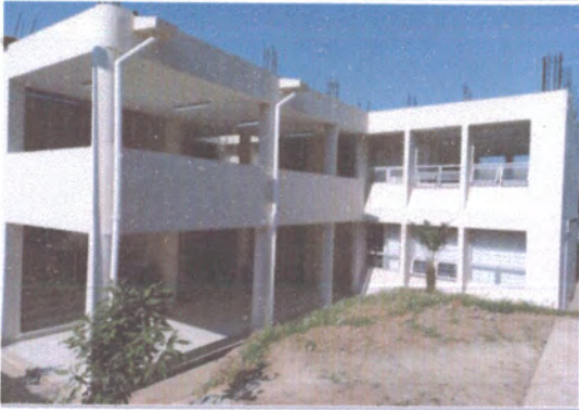
F1: fachada principal
