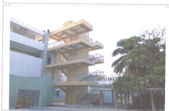
FOTO 8: ESCALERAS DEL EDIFICIO "B"
