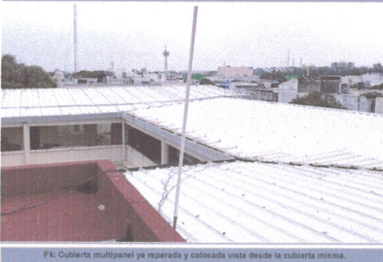
F4: Cubierta multipanel ya reparada y colocada vista desde la cubierta misma.
