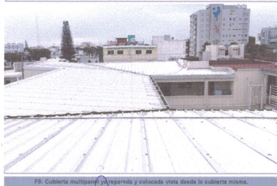
F5: Cubierta multipanel ya reparada y colocada vista desde la cubierta misma.
