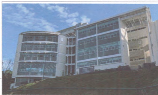
F4: VISTA DE FACHADA
