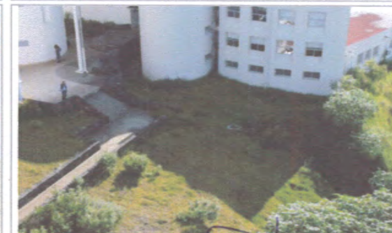
F5: VISTA DE ÁREA DE CISTERNA PLUVIAL
