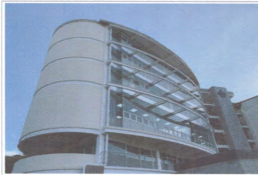
F1: EDIFICIO B VISTA DERECHA
