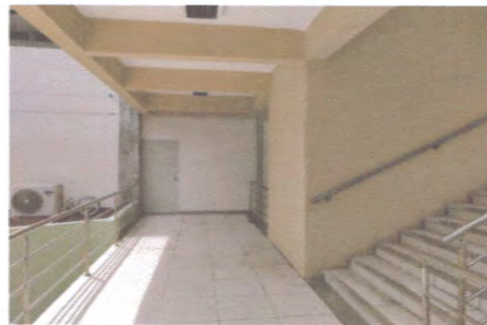
F2: ESCALERAS PRIMER NIVEL
