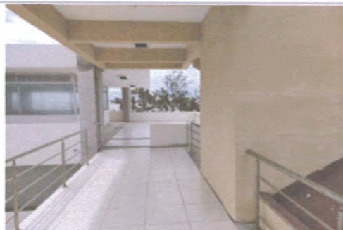
F4: ESCALERAS TERCER NIVEL
