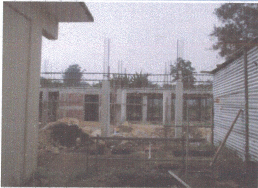
F1: Vista entre Bodega deportes y exterior Edificio I
