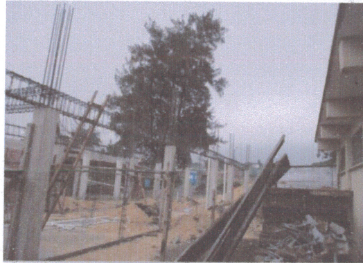
F2: Vista esquina edificio I
