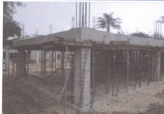
F4: Vista Exterior hacia edificio G
