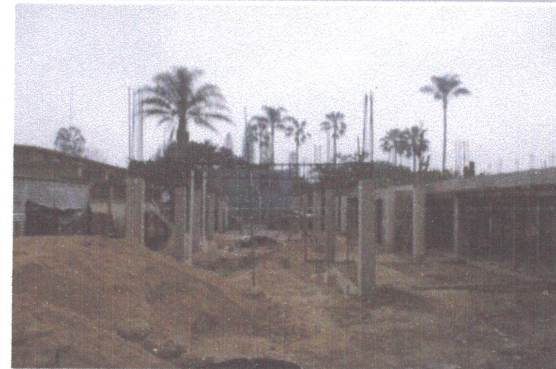
F5: Vista en esquina hacia edificio G
