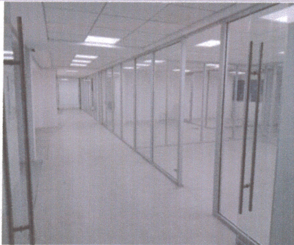
F1: Vista interior área técnico-académica y administrativa
