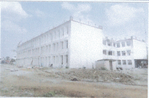
F3: Fachada Norte (segundo nivel)
