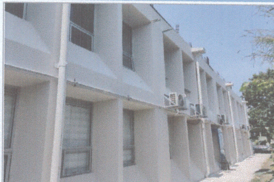
F2: Fachada lateral izquierda
