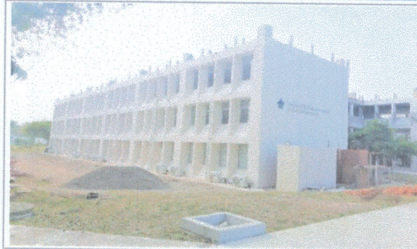
F2: Fachada este (segundo nivel)
