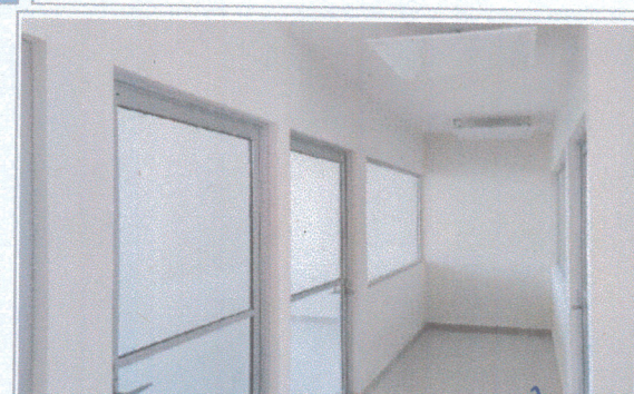
F5: Área de subestación
