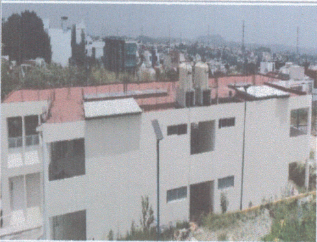
F3: vista general de edificio
