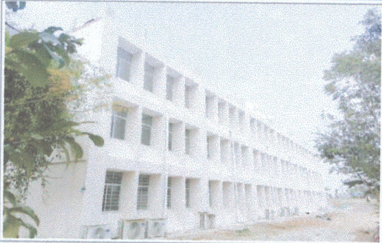
F1: Fachada sur (segundo nivel).
