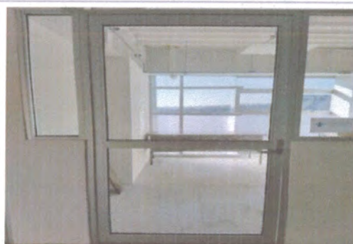
F2: Cubículos último nivel Edificio B
