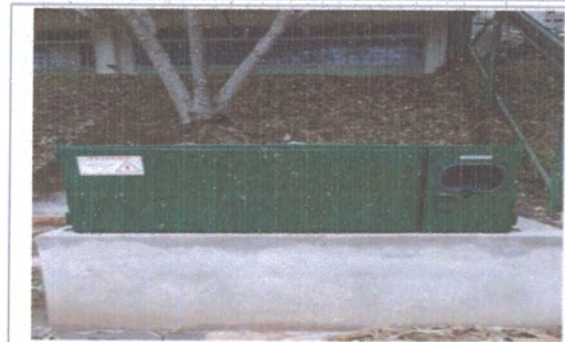
F5: Estacionamiento Área de medición
