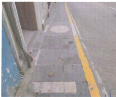
F3: Registro de media tensión en acceso principal
