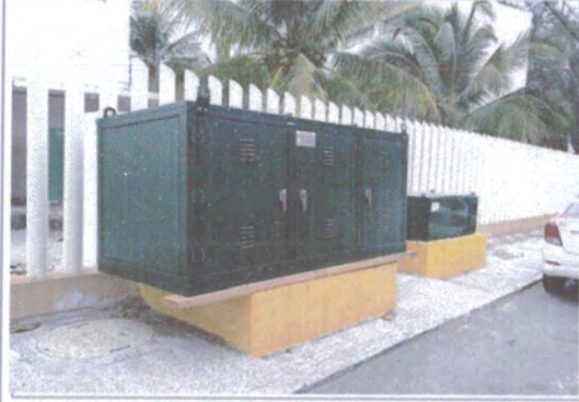
F1: En esta fotografía se observa que el transformador y el equipo de medición ya fueron montados sobre sus bases de concreto. Estos equipos se encuentran sobre la banquetta de la calle Costa Dorada.
