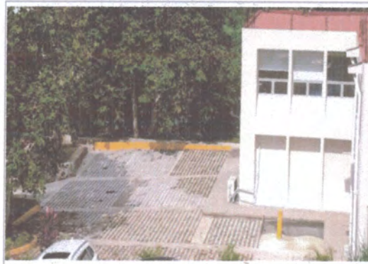
F2: Fachada lateral izquierda
