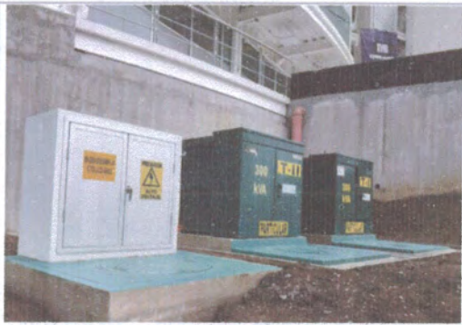
F1: Edificio (B) Entrada principal
