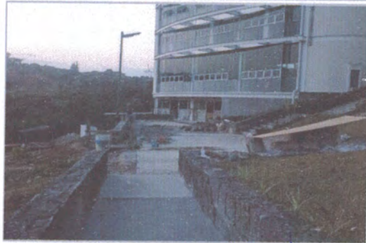
F3: Área exterior Plazoteta
