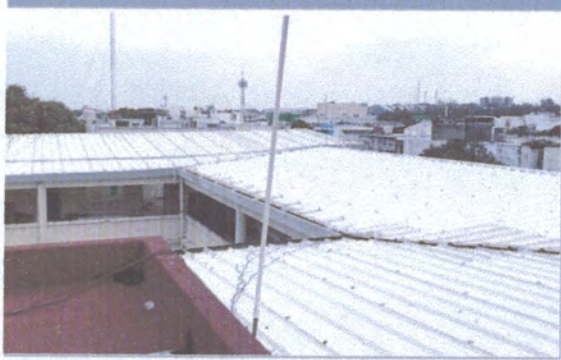
F4: Cubierta multipanel ya reparada y colocada vista desde la cubierta misma.
