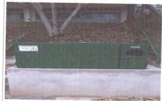
F5: Estacionamiento Área de medición
