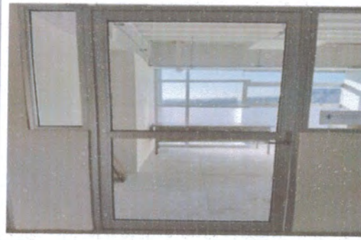
F2: Cubículos ultimo nivel Edificio B
