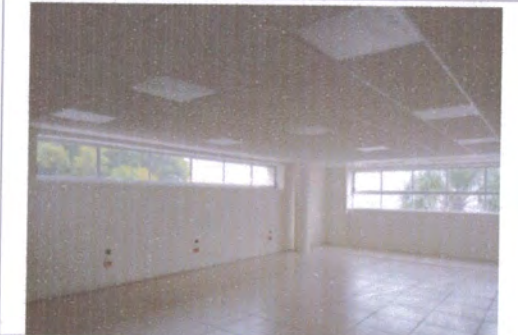
F4: Vista general primer nivel Posgrados
