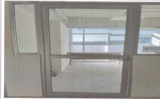
F2: Cubículos último nivel Edificio B
