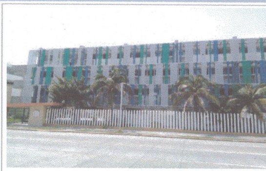
F2: FACHADA EDIFICIO A
