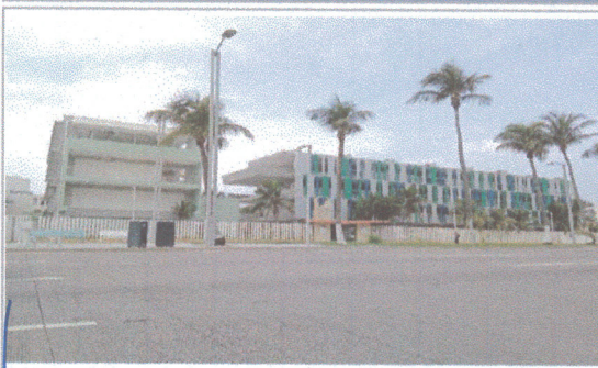
F4: FACHADA EDIFICIO A
