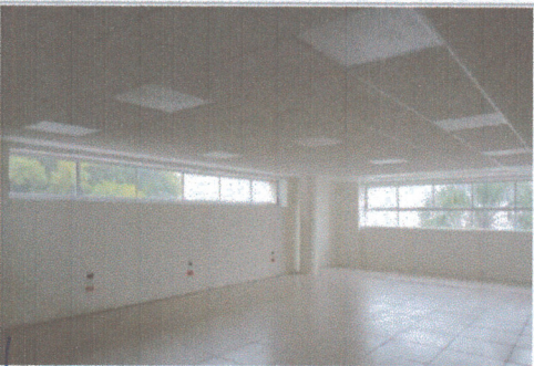
F4: Vista general primer nivel Posgrados
