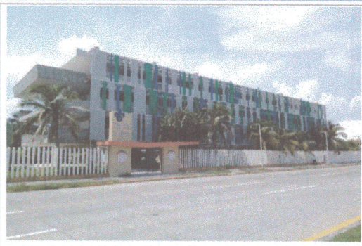
F1: FACHADA EDIFICIO A
