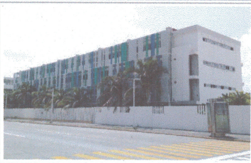
F3: FACHADA EDIFICIO A
