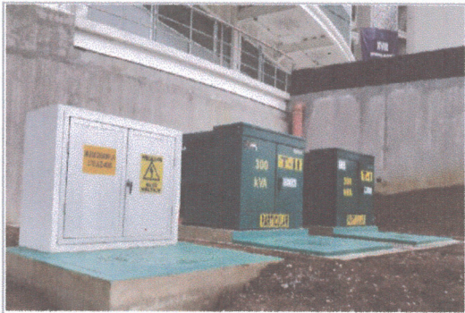
F1: Edificio (B) Entrada principal
