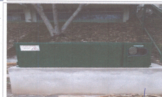
F5: Estacionamiento Área de media tensión
