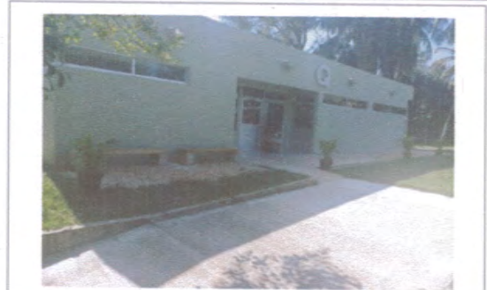
F4: Vista lateral exterior
