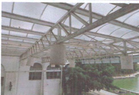
F2: Estado actual de la estructura
