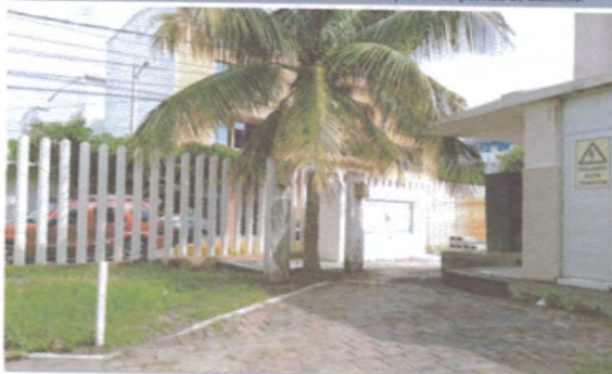
F4: Gabinete ya terminado con la superficie preparada y con las puertas de aluminio ya colocadas, este gabinete alojará al seccionador eléctrico y se encuentra a un costado de la barda perimetral de la Calle Costa Verde.
