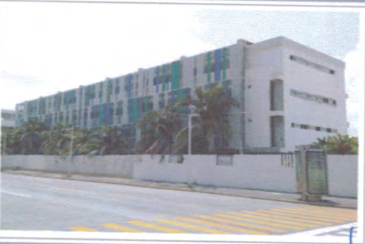
F3: FACHADA EDIFICIO A
