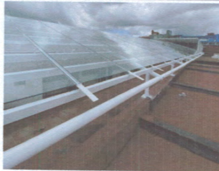
P4: Vista desde azotea 2
