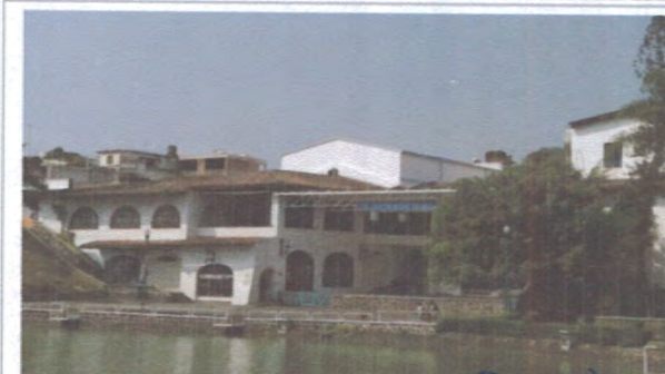
F5: Vista del foro abierto en pasaje Obra concluida
