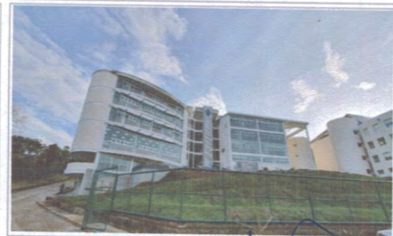
F5: Edificio C: Fachada Posterior
