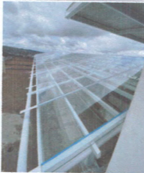
P1: Vista desde azotea 1
