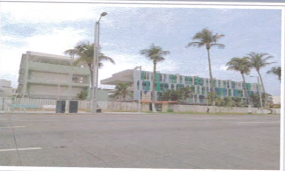
F4: FACHADA EDIFICIO A
