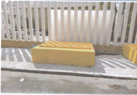
F1: Registros prefabricados ya colocados y con las bases de concreto terminadas y listas para recibir a los equipos de medición.
