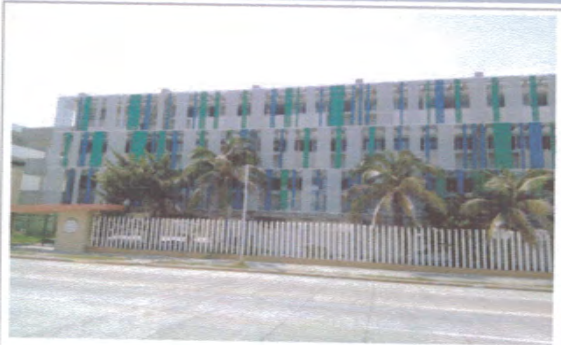
F2: FACHADA EDIFICIO A
