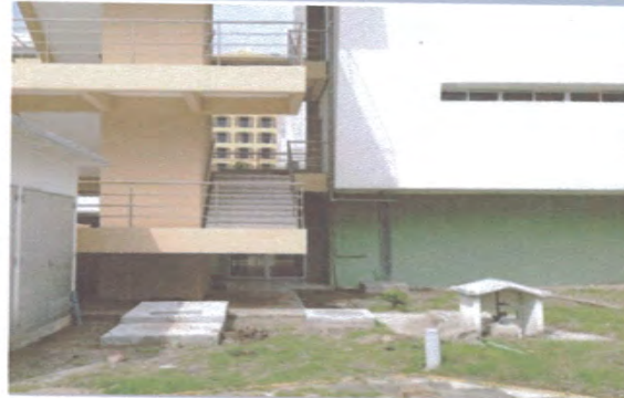
F2: Registro y base prefabricada listos para recibir el transformador de 500 kva indicado en el proyecto. A la izquierda se observa el cuarto de tableros ya con las puertas de aluminio.
