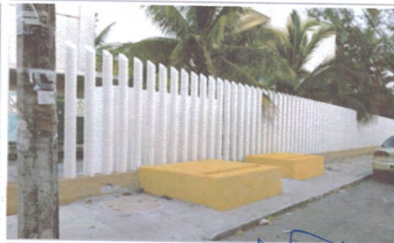
F5: Bases ya terminadas y en espera del suministro de los equipos de medición. Ambas bases se localizan en el exterior de la Unidad de Ingeniería sobre la Calle Costa Verde.
