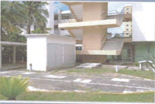
F3: Cuarto de tableros ya construido, con la superficie preparada y con las puertas de aluminio ya colocadas, al costado del mismo se observa el registro con su base prefabricada donde se colocará el transformador de 500 kva.
