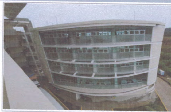
F2: Edificio A: Fachada Interior
