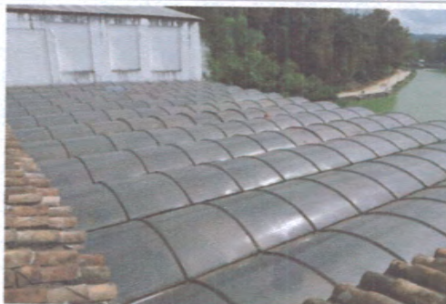
F4: Estado actual cubierta foro abierto
