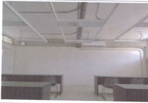
F1: Vista del interior de un aula terminada en el segundo nivel
