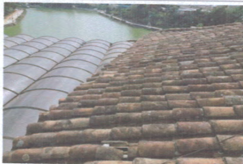
F3: Estado actual integración de cubierta
