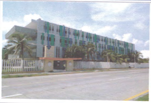
F1: FACHADA EDIFICIO A
