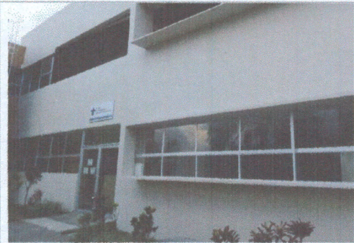
F1: Fachada principal
