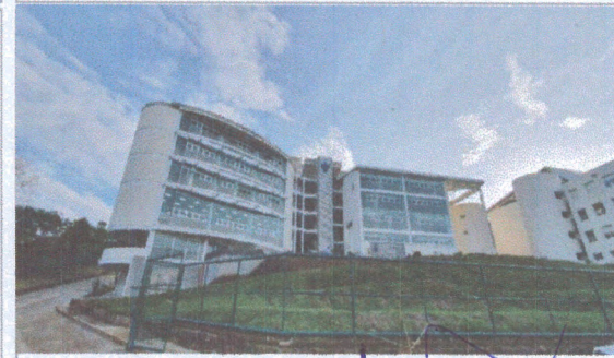
F5: Edificio C: Fachada Posterior
