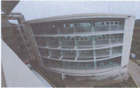
P2: Edificio A: Fachada Interior
